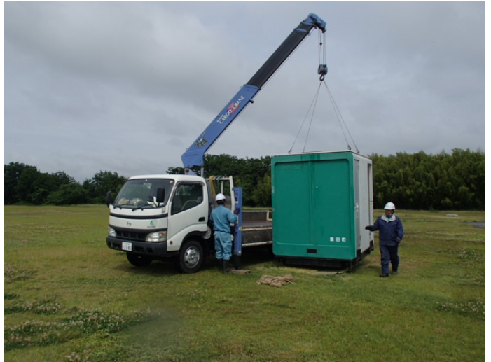
河川内公園の仮設トイレ搬出訓練
