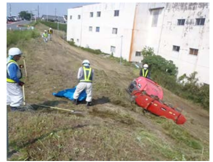
除草作業状況
