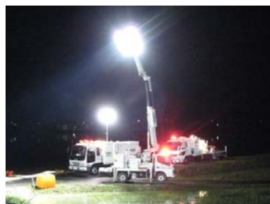
洪水時における支援状況 (排水ポンプ車による排水活動 幸田町 広田川 平成20年8月)
