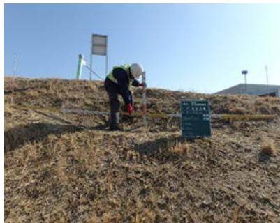
堤防点検の実施状況
