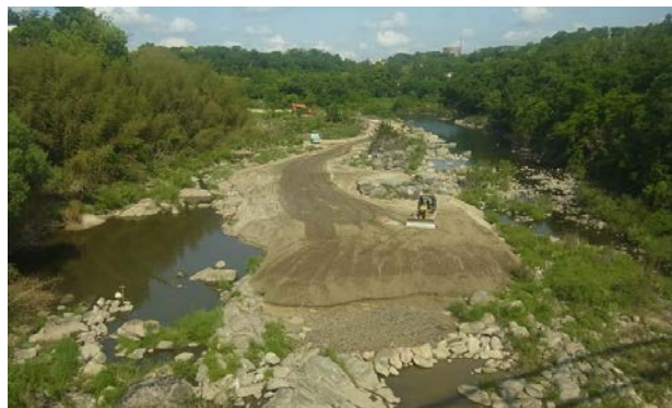
置土実験の実施状況（令和元年5月）
