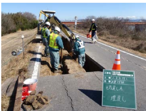
堤防の補修作業の状況
