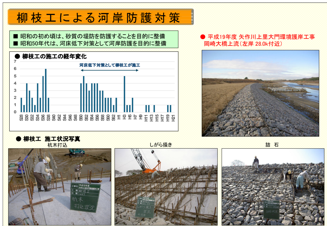
図 6.1 矢作川における柳枝工による河岸防護対策
