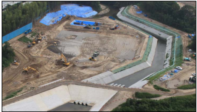
H26.7時点（分派施設本体工基礎地盤整正）
