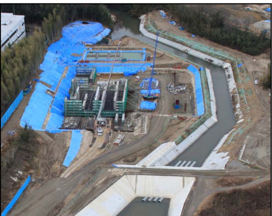
H27.1時点（鉄筋組立）
