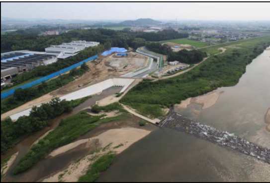
H26.7時点（分派施設本体工基礎地盤整正）
