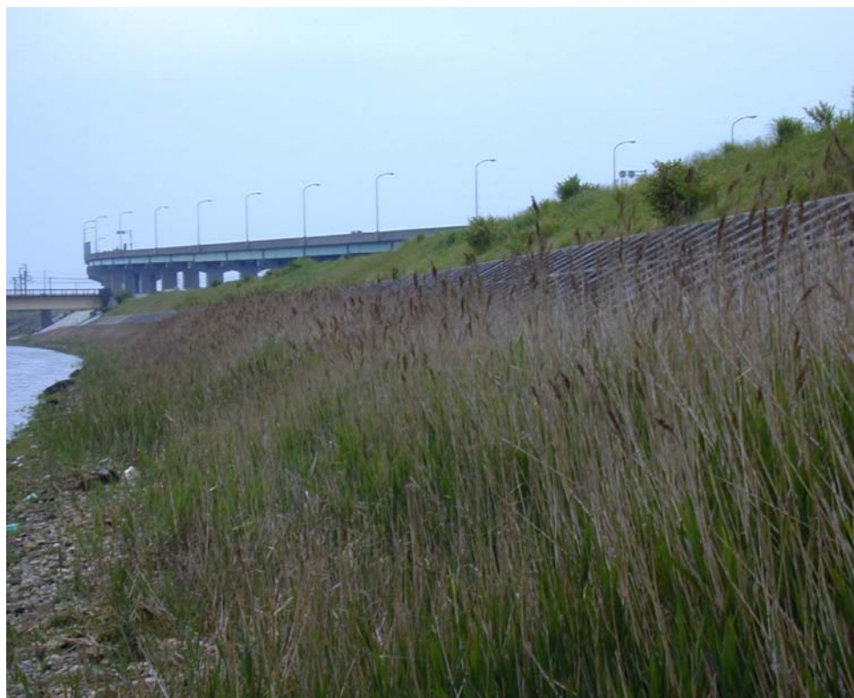
護岸前面に移植したヨシの生育状況 (豊川放水路：小坂井町平井)
