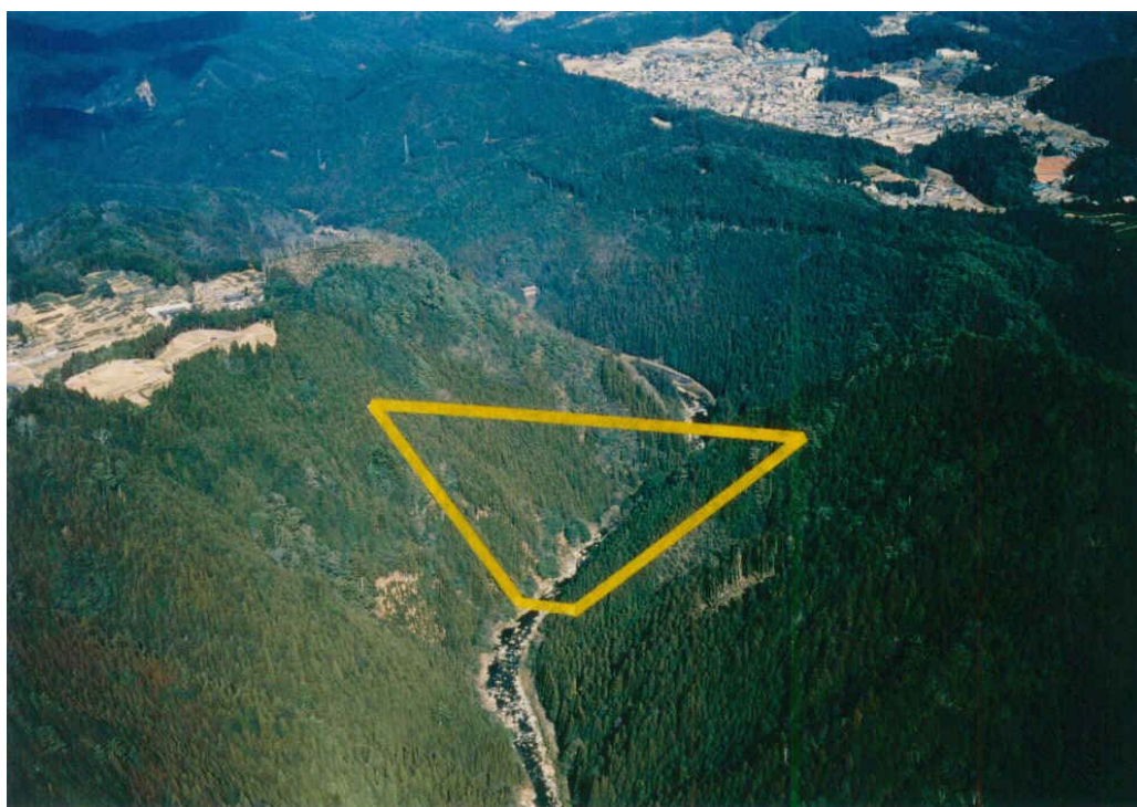
設楽ダム建設予定地の状況 (北設楽郡設楽町清崎、松戸)
