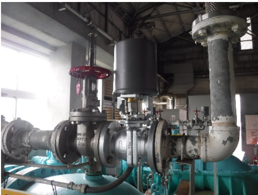
ポンプ設備の更新
