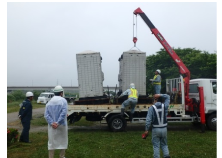
河川内公園のトイレ撤去搬出訓練
