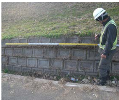
堤防点検の状況
