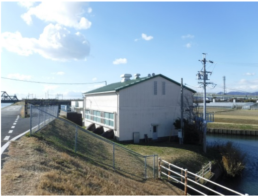
小坂井排水機場
