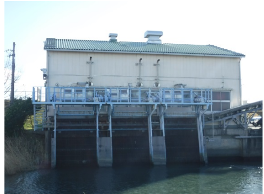
除塵機の更新
