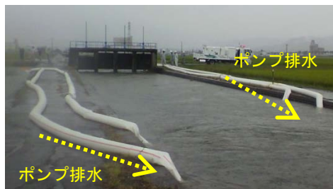
湛水被害時における支援状況 (排水ポンプ車による排水活動 豊川市 善光寺川 平成27年9月)
