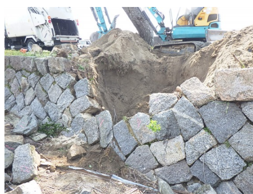
石積みの補修状況
