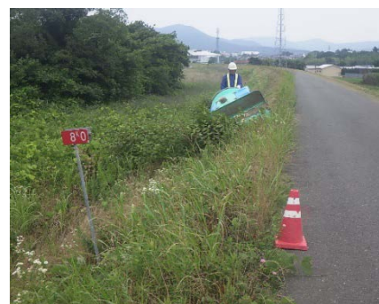
除草作業状況
