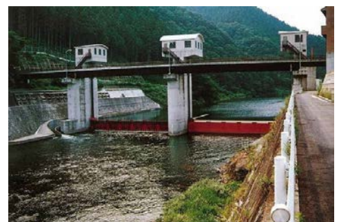
寒狭川堰 (平成14年度 完成)
