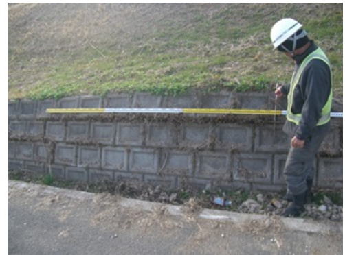
堤防点検の状況
