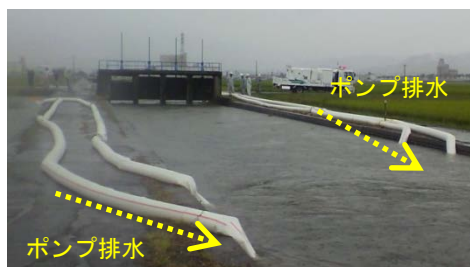
湛水被害時における支援状況 (排水ポンプ車による排水活動 豊川市 善光寺川 平成27年9月)
