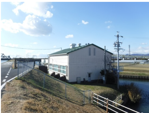
小坂井排水機場
