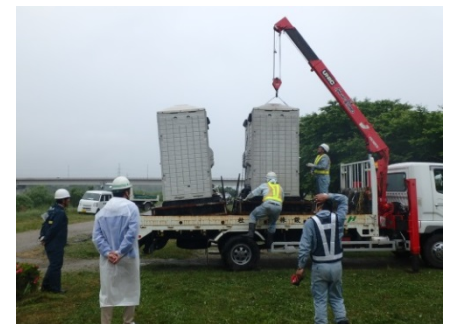
河川内公園のトイレ撤去搬出訓練
