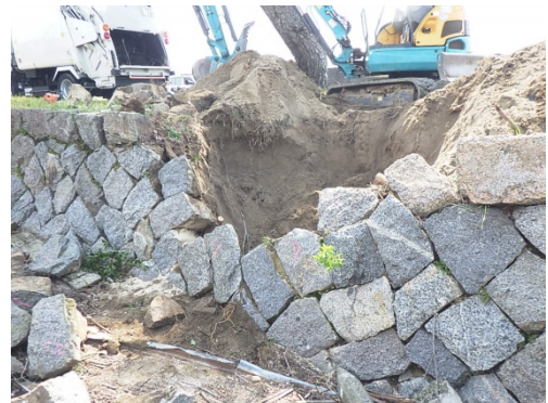
石積みの補修状況
