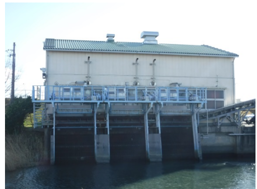
除塵機の更新
