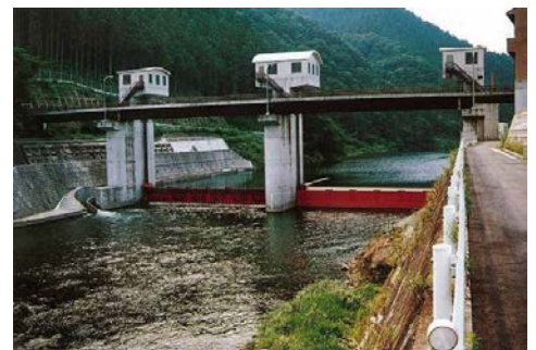
寒狭川堰 (平成14年度 完成)
