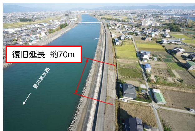
豊川放水路左岸(豊橋市清須地区)
