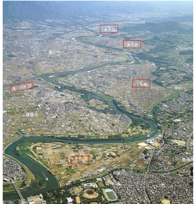
霞堤地区を含む豊川遠景
