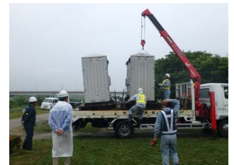
河川内公園のトイレ撤去搬出訓練
