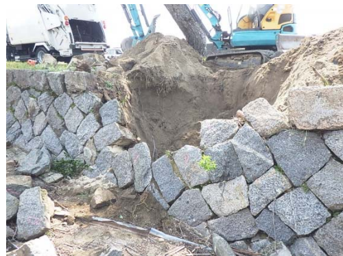
石積みの補修状況
