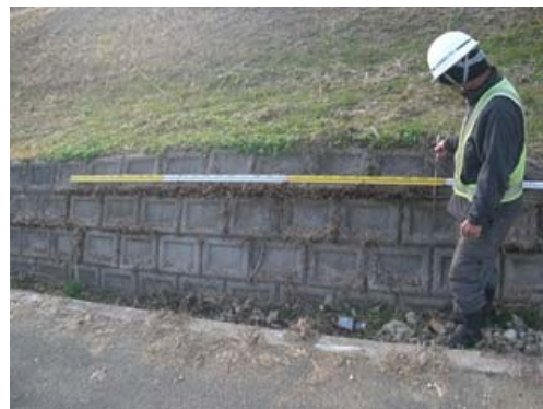
堤防点検の状況
