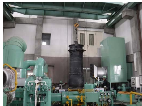
排水ポンプの整備
