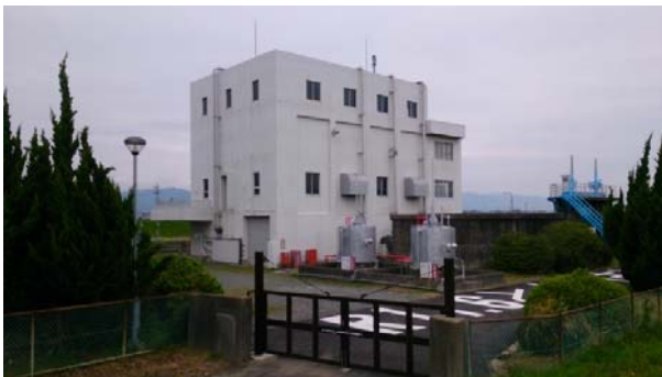
古川排水機場
