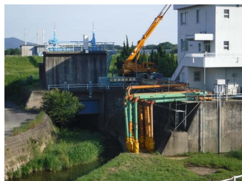
排水ポンプの修繕工事（古川排水機場）
