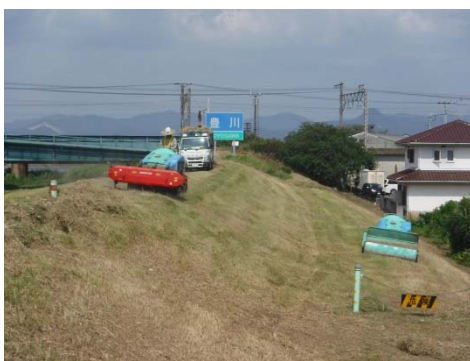
堤防の除草作業状況
