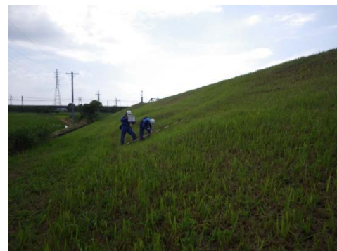
堤防の点検実施状況
