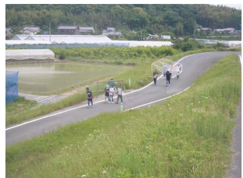
ゴールネット撤出。 ～増水時の川の流れを守る～
