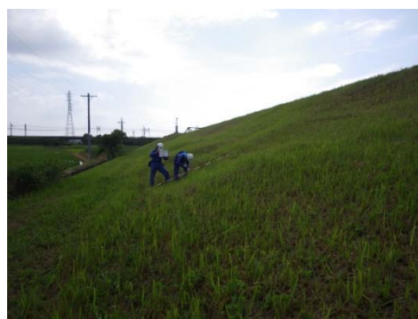
堤防の点検実施状況
