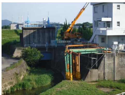
排水ポンプの修繕工事（古川排水機場）
