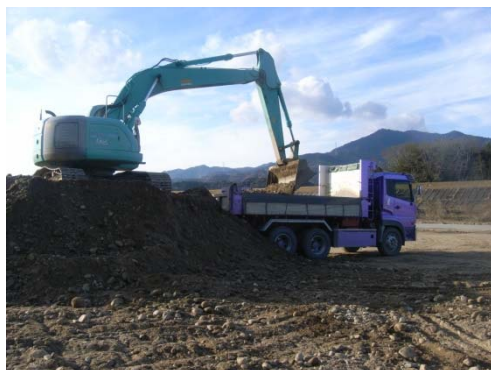
区画整理地内への土砂運搬状況
