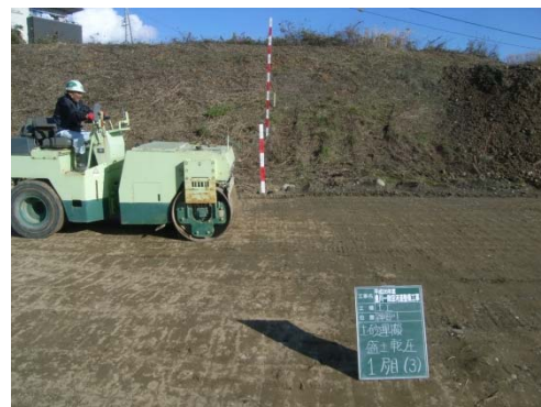
運搬土の転圧状況
