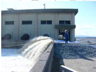
東日本大震災被災での支援状況 (津波浸水地区の排水作業 南相馬市 H23.4)
