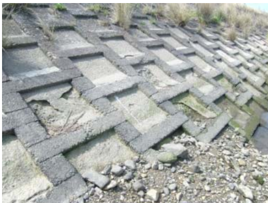
老朽化した護岸(イメージ)
