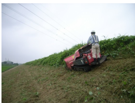
異常を早期発見するための 堤防除草
