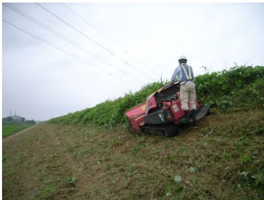
■堤防除草作業状況
