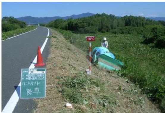
■堤防除草作業状況
