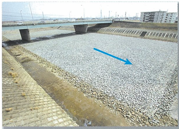
豊川放水路護床工事 (豊川市正岡地区)
