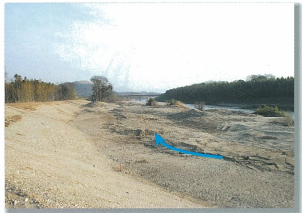
河道整備工事 (豊川市松原地区)
