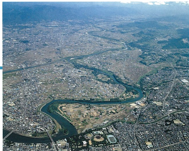
7.0km地点より上流を望む
