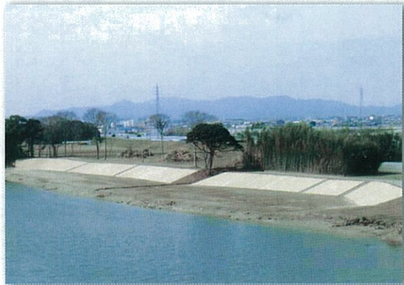
大村河道掘削 平成15年度完成(8.3km地点)
