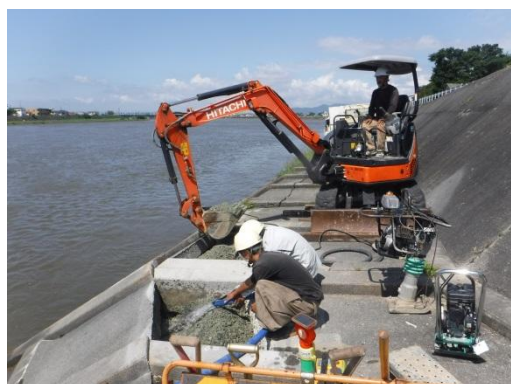
護岸の補修状況
