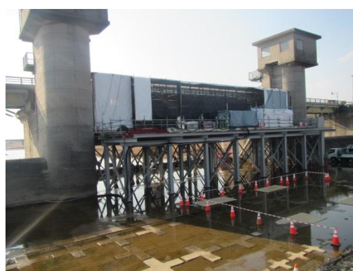
分流堰ゲートの修繕状況
