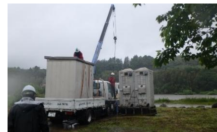
河川内公園のトイレ撤去搬出訓練
