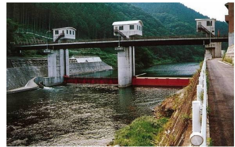
寒狭川堰(平成14年完成)
