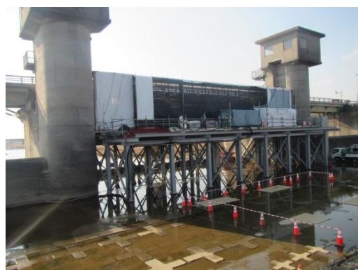
分流堰ゲートの修繕状況
