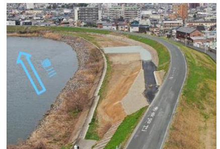
豊川アダプト【リバーサイドボランティア】地域からの要望により、河川敷を整備 今後、除草・清掃活動予定 (豊橋市下地 R4高水敷整備)
