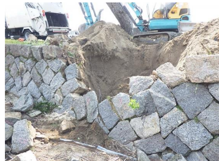
石積みの補修状況
