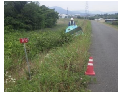
除草作業状況
