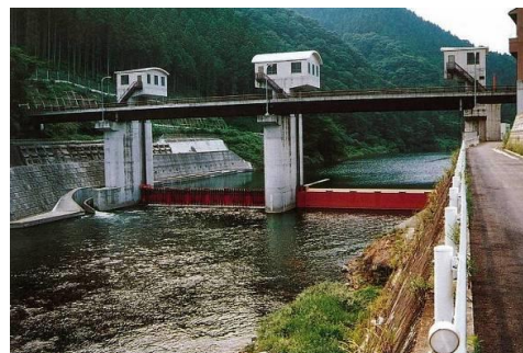
寒狭川堰 （平成14年度 完成）
