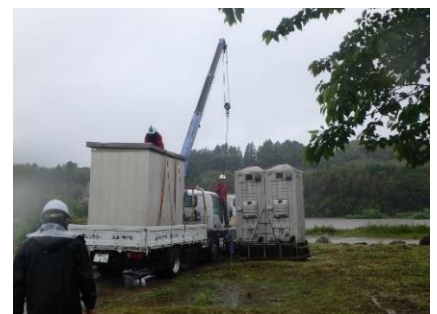
河川内公園のトイレ撤去搬出訓練
