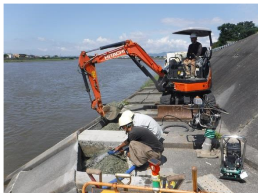
堤防のコンクリート護岸の補修状況
