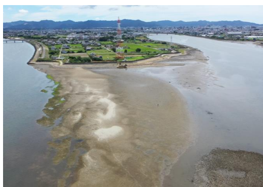
出水後(令和5年7月31日撮影) 前芝水位:0.24m
