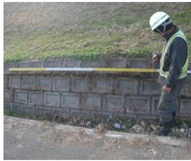
堤防点検の状況
