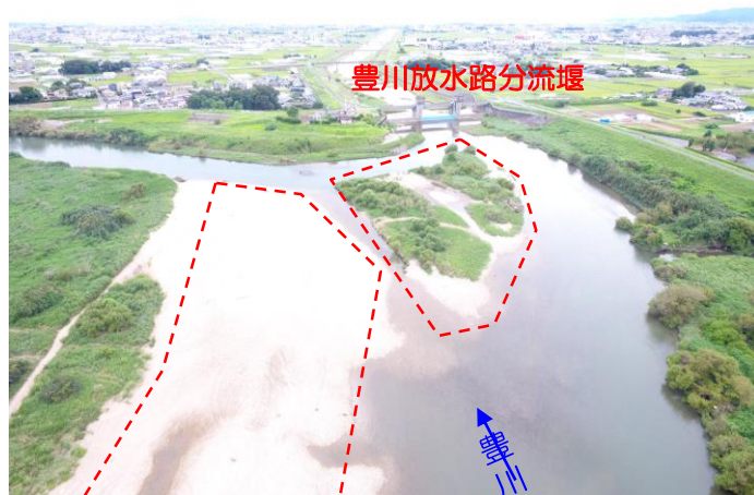
掘削状況（令和3年度 豊川市行明地区）
