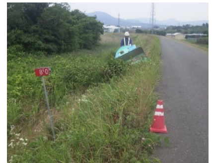
除草作業状況
