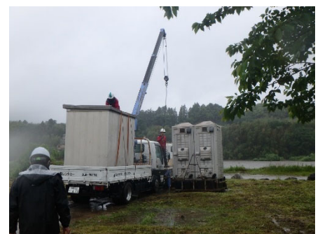
河川内公園のトイレ撤去搬出訓練
