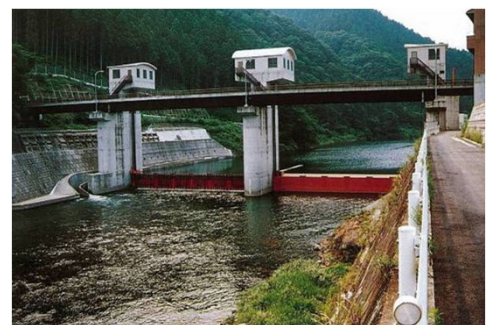
寒狭川堰 (平成14年度 完成)
