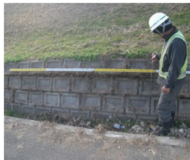
堤防点検の状況
