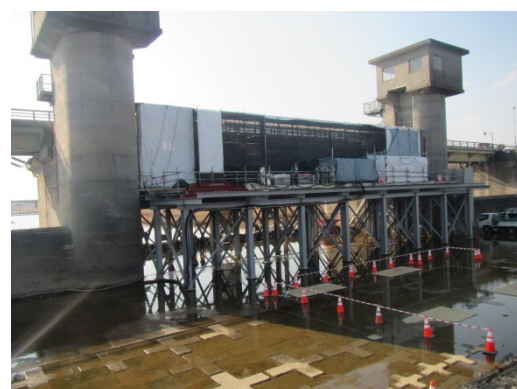
分流堰ゲートの修繕状況
