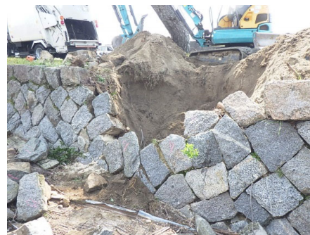
石積みの補修状況
