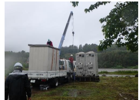
河川内公園のトイレ撤去搬出訓練
