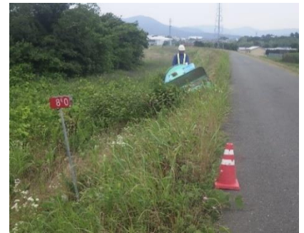
除草作業状況
