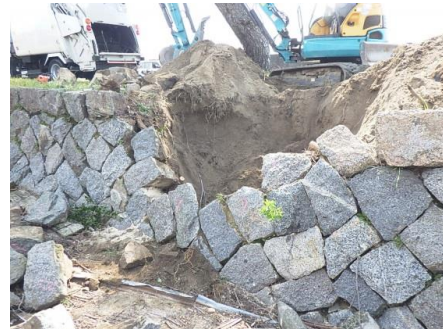
石積みの補修状況
