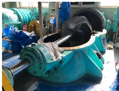
ポンプ設備分解整備
