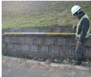
堤防点検の状況
