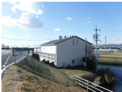
小坂井排水機場
