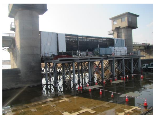
分流堰ゲートの修繕状況
