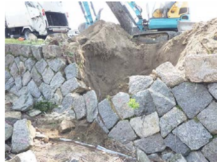
石積みの補修状況
