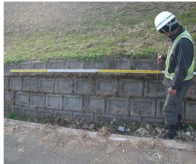
堤防点検の状況
