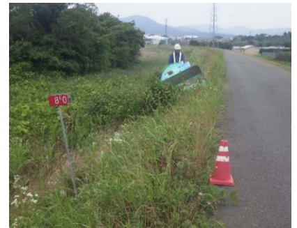
除草作業状況
