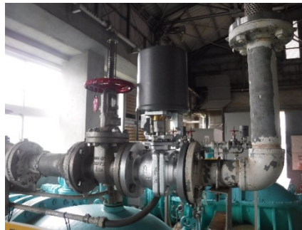
ポンプ設備分解整備
