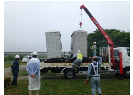
河川内公園のトイレ撤去搬出訓練
