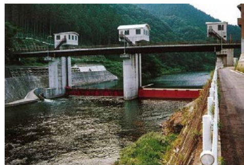
寒狭川堰 (平成14年度 完成)
