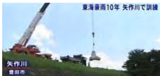
ブロック投入による荒締切の訓練状況
