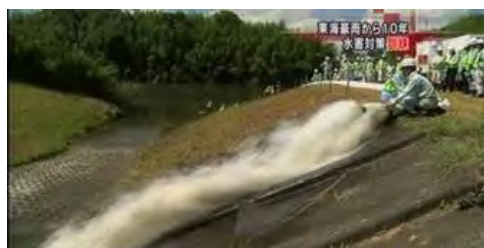
排水ポンプ車による排水ポンプ稼働状況
