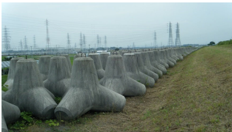
矢作川右岸7.4k付近に備蓄されているブロックの状況
