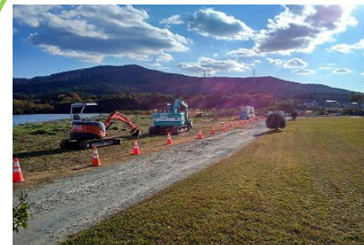
河川維持工事
