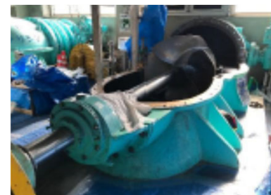
ポンプ設備分解整備
