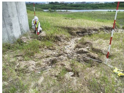
堤防・護岸点検
