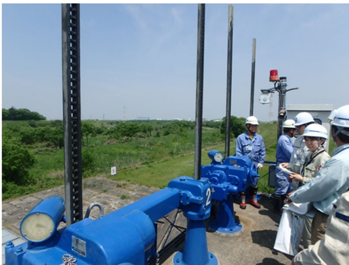
令和元年度 出水期前点検の様子（許可施設管理者との合同点検）
