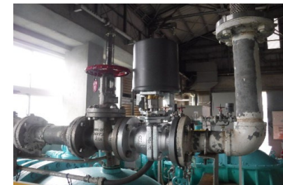
ポンプ設備分解整備
