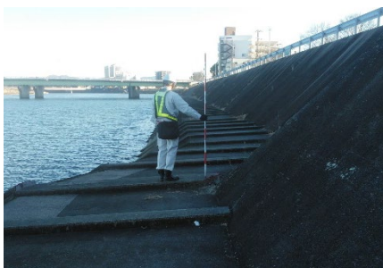
堤防・護岸点検
