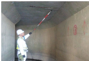
直轄樋管函体の点検
