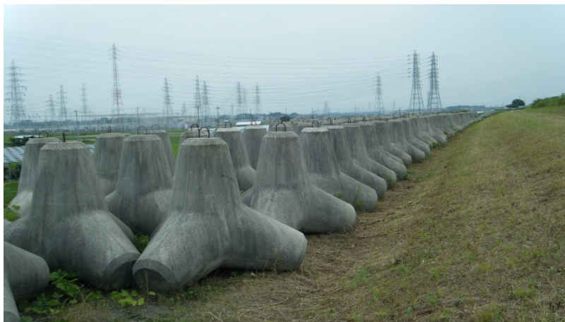
矢作川右岸7.4k付近に備蓄されているブロックの状況
