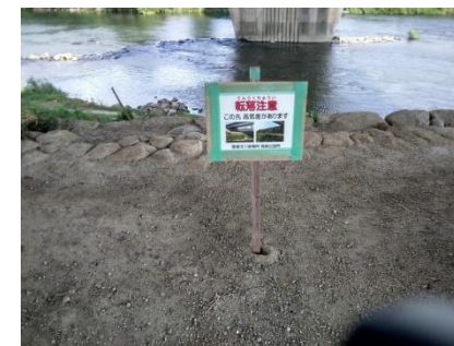
転落防止注意看板の設置
