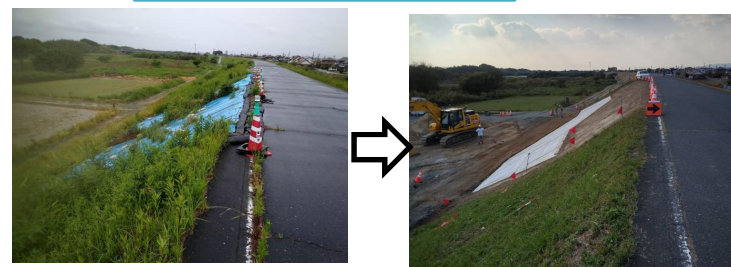
堤防法面補修工事の状況
