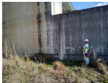
河川構造物の点検
