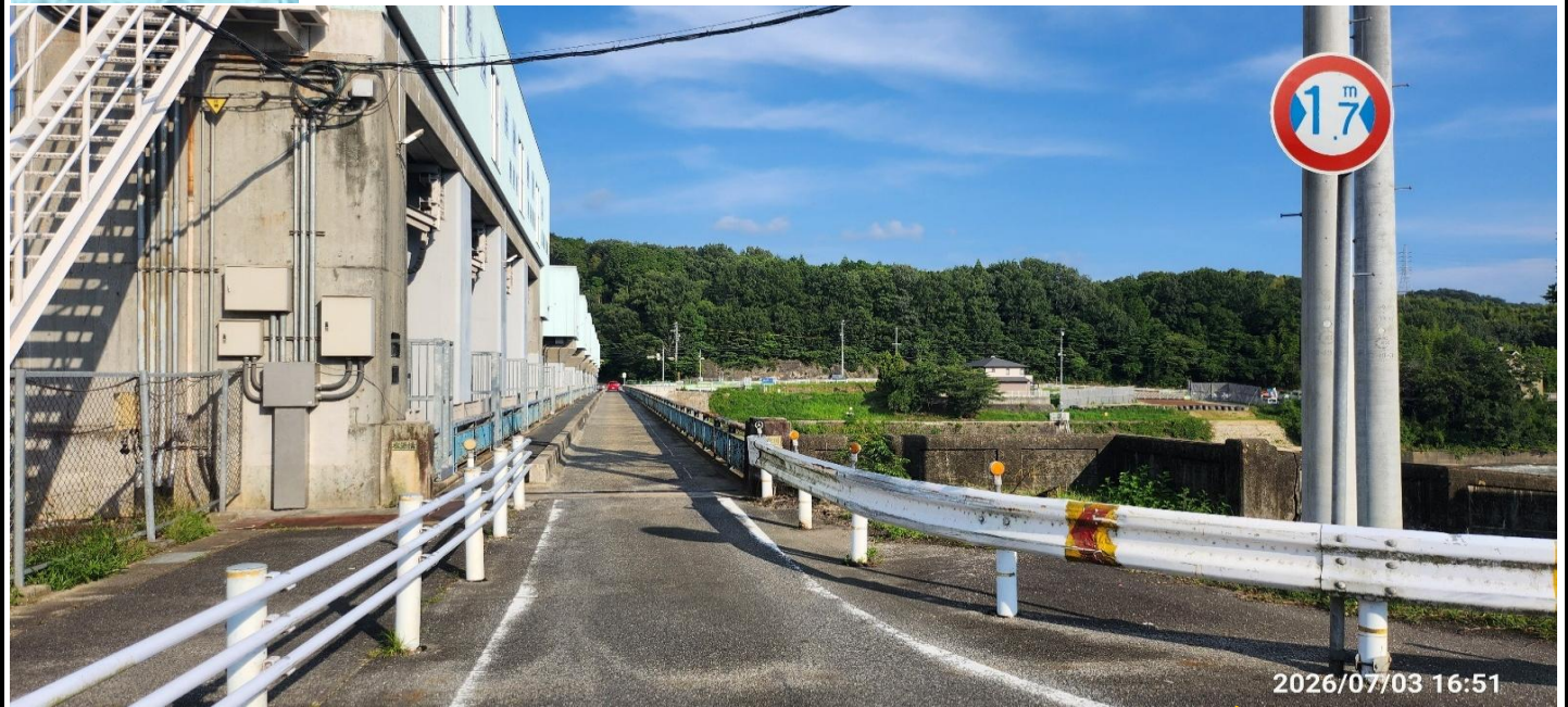
《水源橋③》 開通した水源橋の様子。
