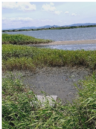
1.5km付近、道から見えない所にもベッドのクッション
