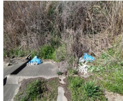
左岸3.4km付近、小石混じりの土砂の不法投棄があった。
