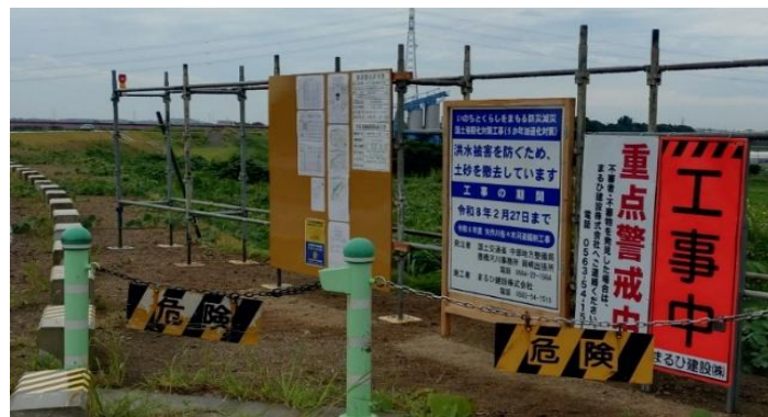
① 工事を告知する様々な看板
