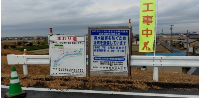
① 渡橋付近に通行止めの看板 堤防の整備が3月まで続く
