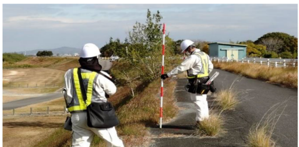
②堤防の点検作業に取り組む作業員 「年2回行う」と説明してくれました
