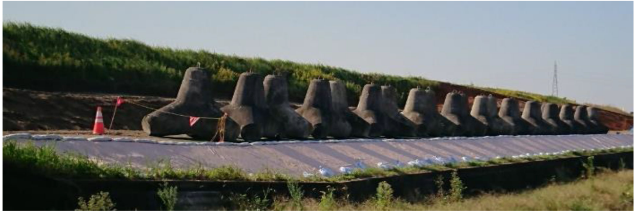
①護岸工事で、堤防外側にも巨大なテトラポットが並ぶ(19Km付近の右岸堤防)
