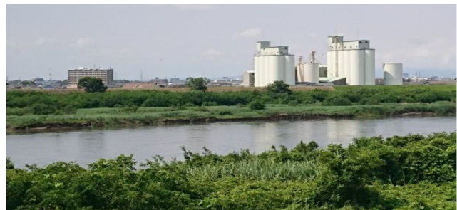
①増水した渡橋下流付近の 矢作川
