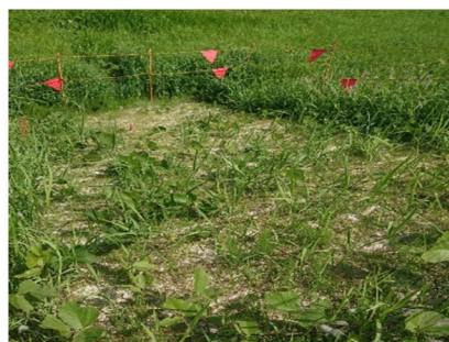
左岸側の裏法面の補修地も だいふ草が生え始め元に戻ってきている。
