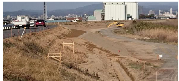
③固められた堤防ののり面
