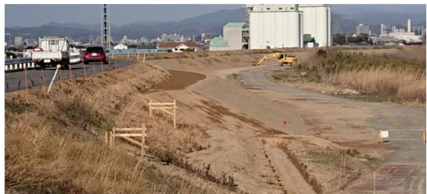
③固められた堤防ののり面
