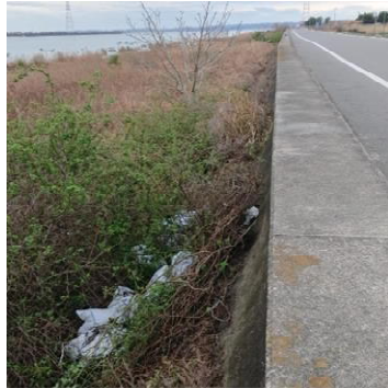
右岸 0.8~0.9km付近
