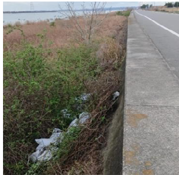
右岸 0.8~0.9km付近
