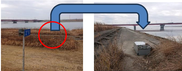
左岸 2.6km 高水敷下のコンクリート面に冷蔵庫がある。 堤防の上からは、草があって見えない。 2024.2.15
