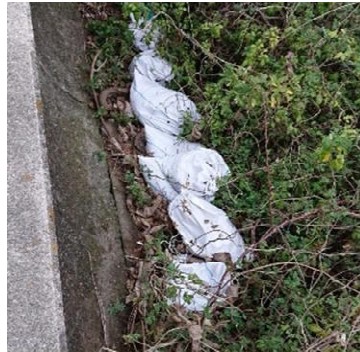
右岸 1.0km付近
