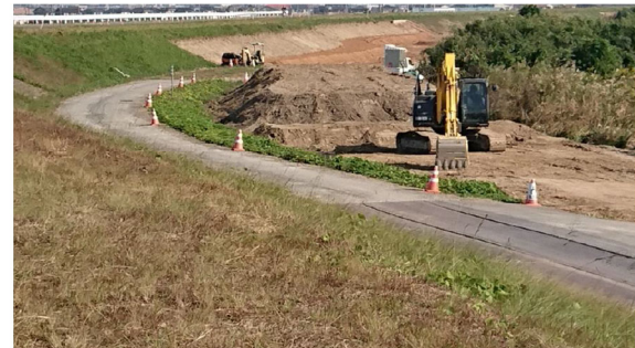
③堤防内の整備を続ける重機
