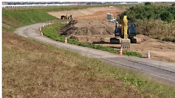
③堤防内の整備を続ける重機
