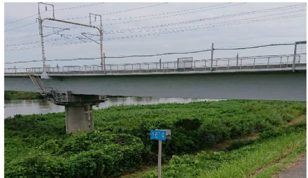
① 野草が密集する新幹線橋梁付近
