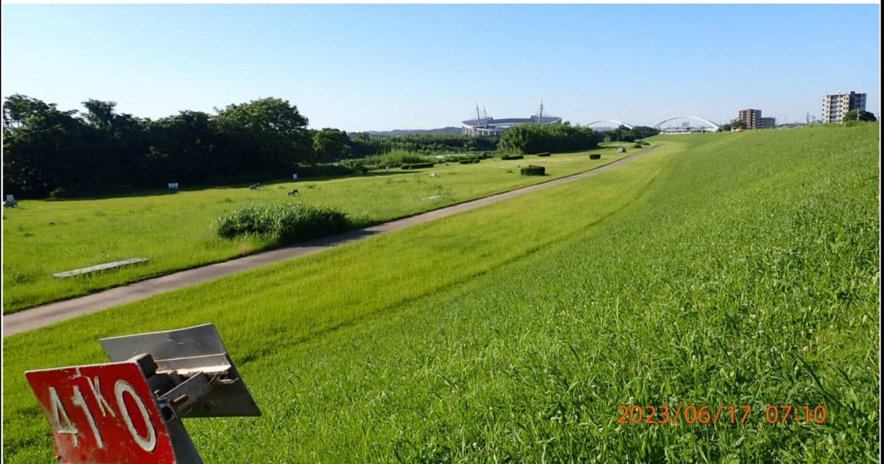
右岸41.0km付近より下流側を撮影。 緑が清々しく見える。
