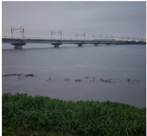
右岸16.6km付近より JR東海道新幹線架橋を撮影。
