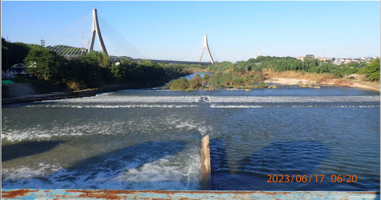
水源橋付近の様子（3）水源橋（中央）より下流を撮影。
