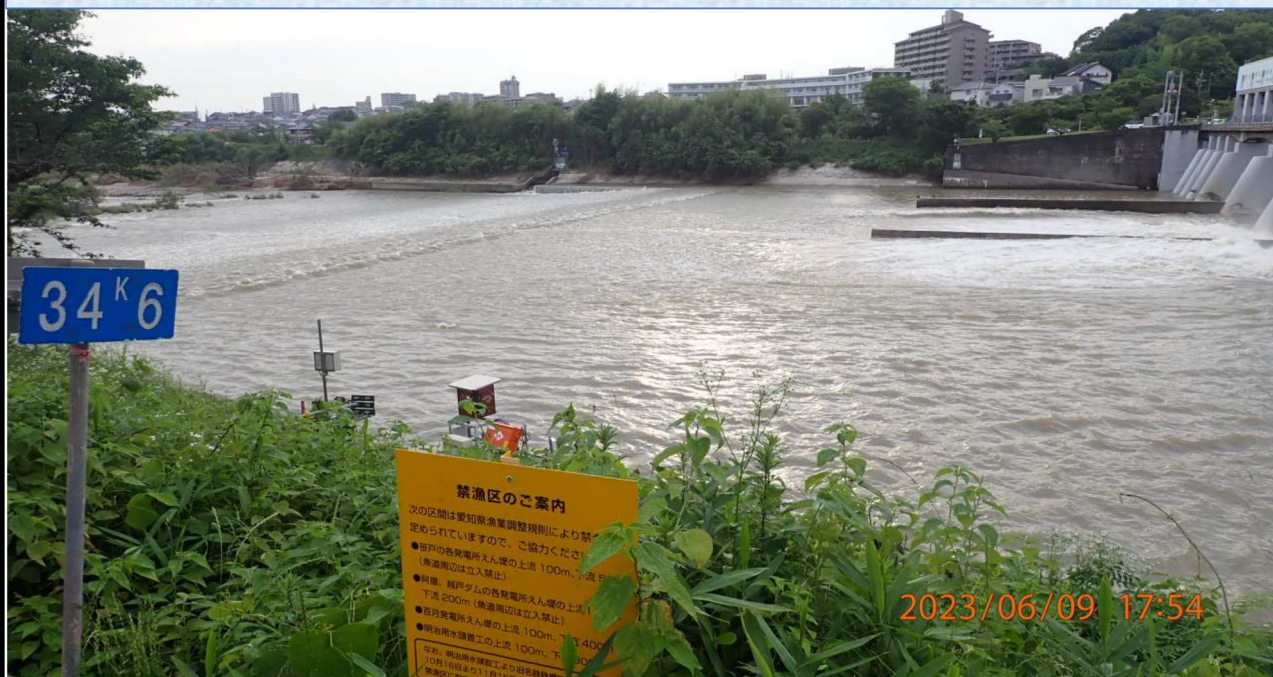
水源橋付近の様子（1）左岸34.6km付近より対岸を撮影。 工事の様子は見られなかった。
