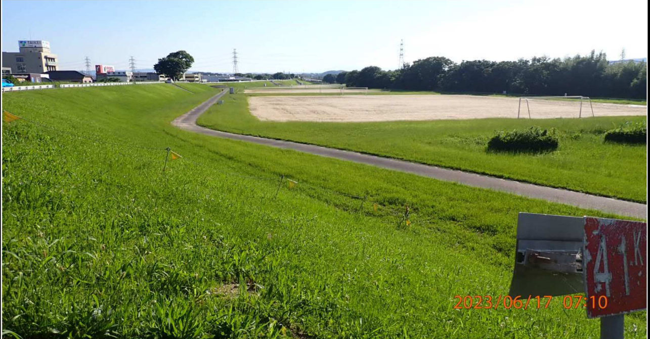
右岸41.0km付近より上流側を撮影。
