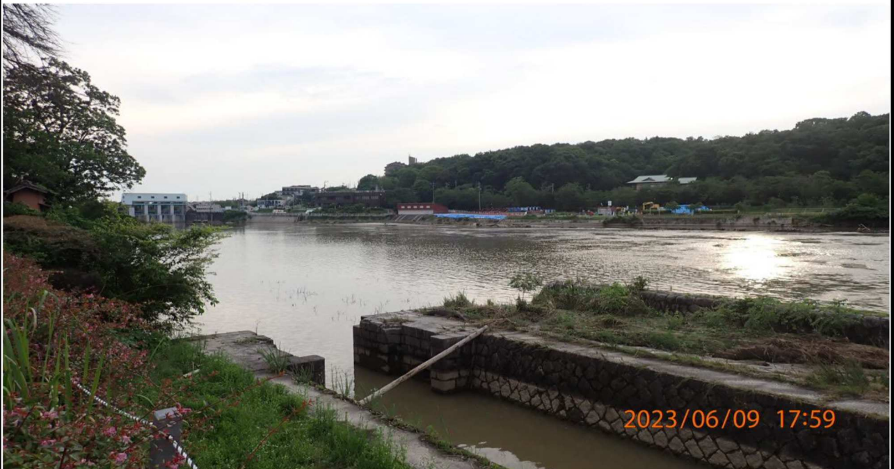
明治用水旧頭首工付近の様子（2） 左岸35.0km付近より下流を撮影。
