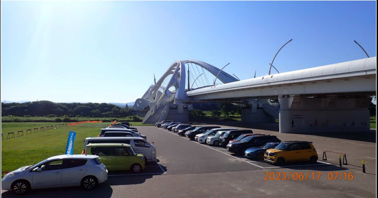
右岸40.0km付近の白浜公園駐車場を撮影。 早朝から多くの利用者がみえた。
