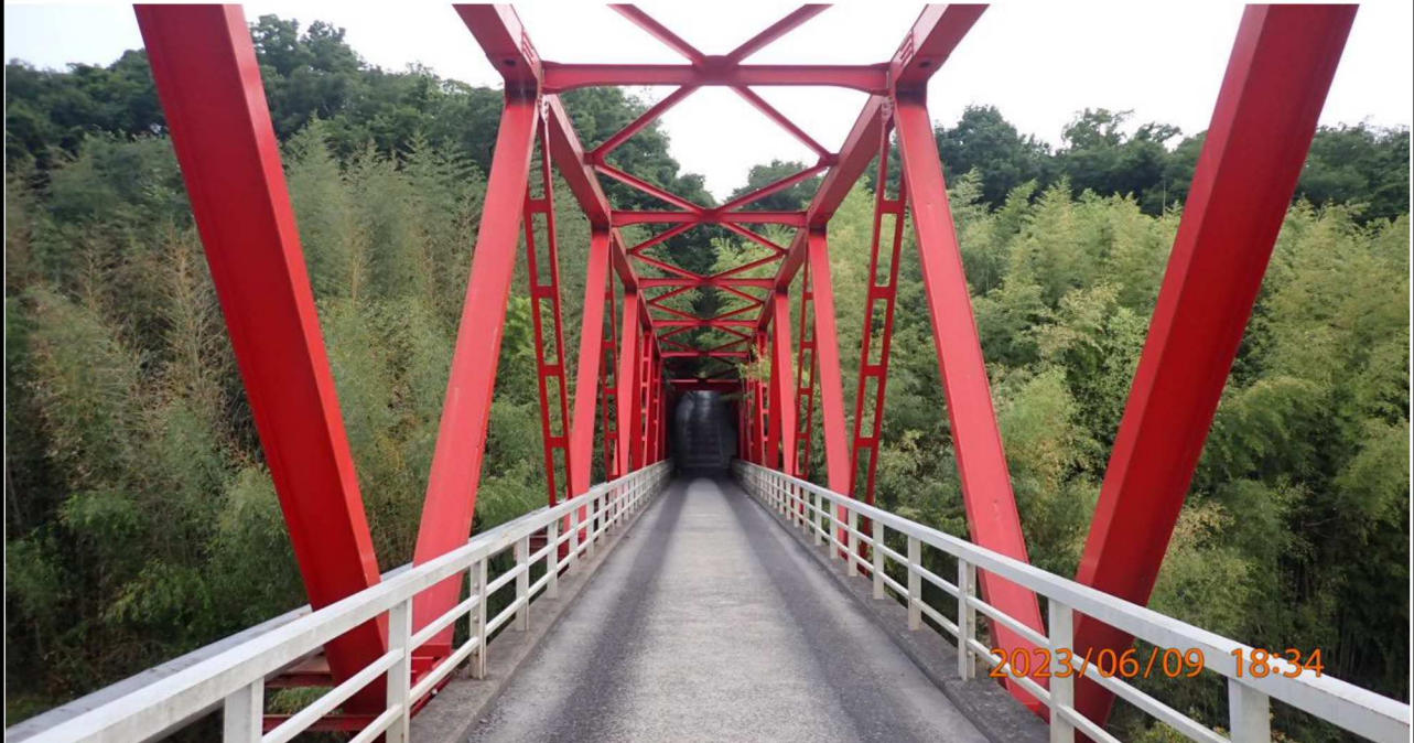
鵜の首橋付近の様子（3）鵜の首橋左岸より対岸を撮影。
