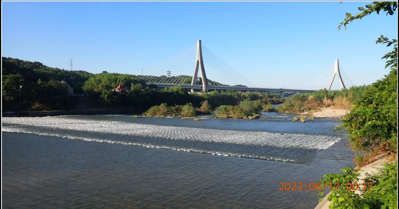
水源橋付近の様子（1）水源橋（右岸）より下流を撮影。
