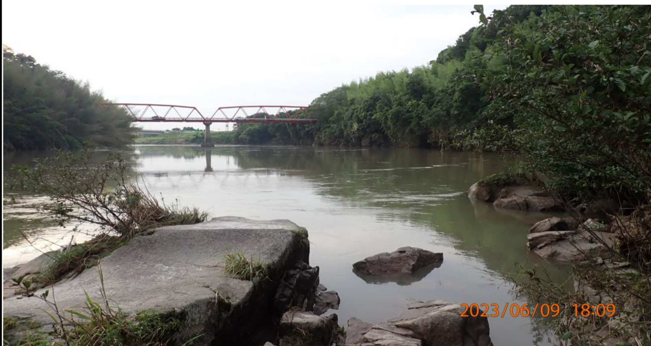
鵜の首橋付近の様子（2）左岸37.2kmより上流を撮影。
