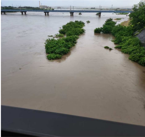
矢作橋右岸から下流を撮影。
