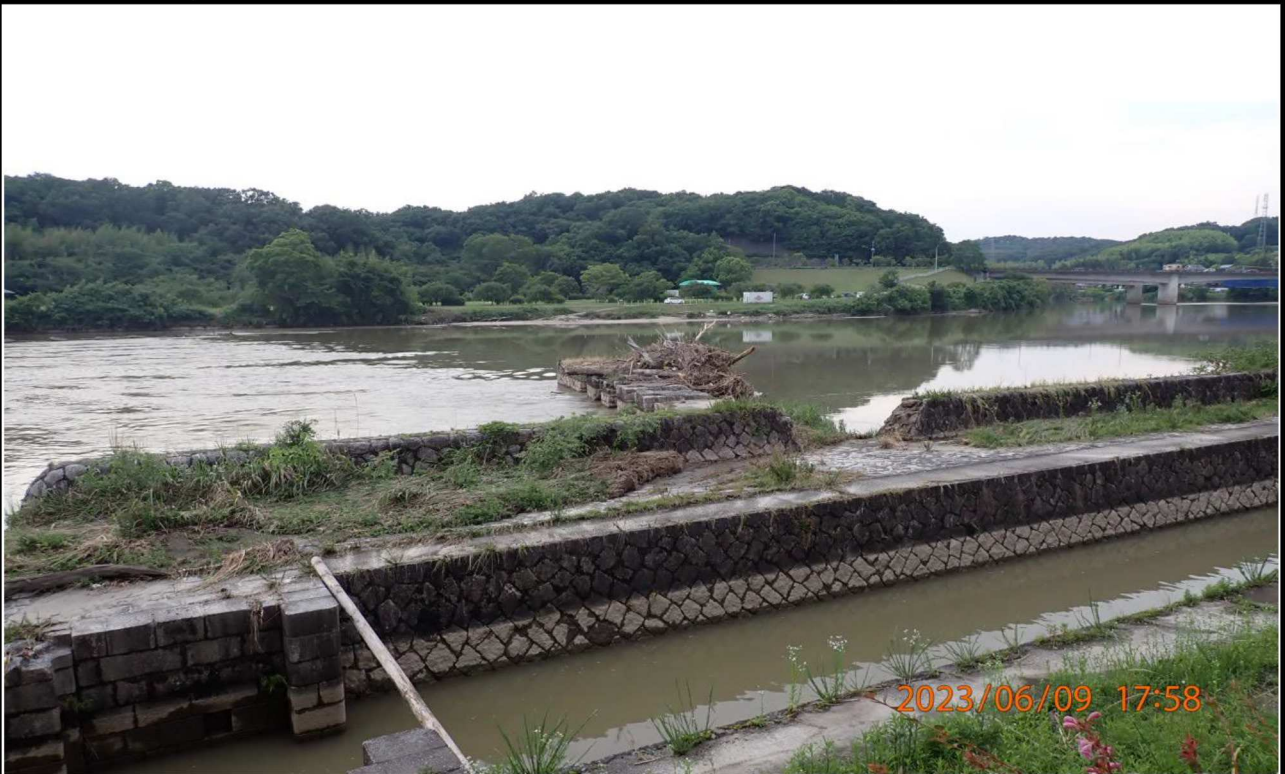
明治用水旧頭首工付近の様子（1） 左岸35.0km付近より上流を撮影。
