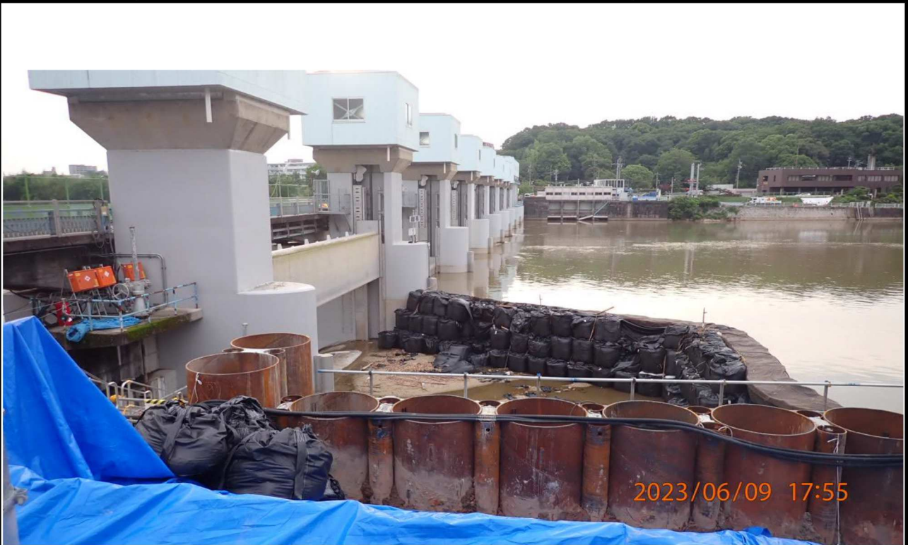
水源橋付近の様子（3）水源橋（上流側）を撮影。 1号ゲート（P1堰柱とP2堰柱間）部に堰が作られている。
