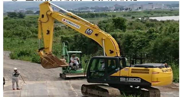
③ 重機による作業が続く 18.6Km付近右岸
