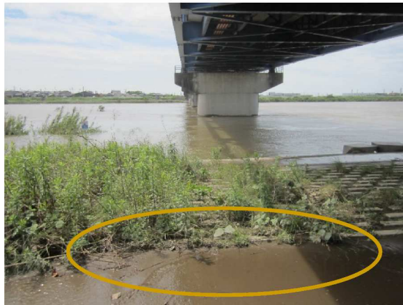
中畑橋下左岸では水位がコンクリートブロックに乗った痕跡アリ
