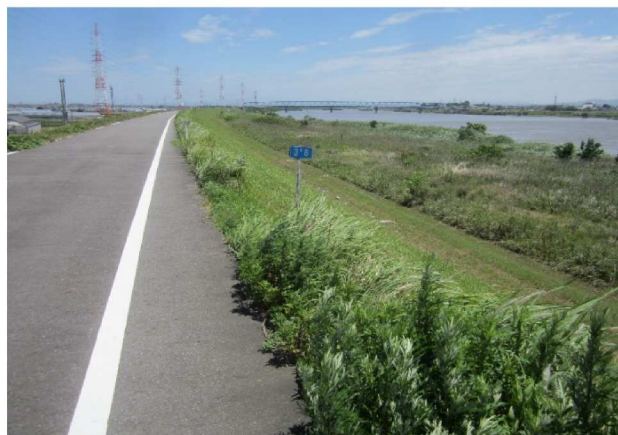
右岸3.8km付近から上流方向撮影
