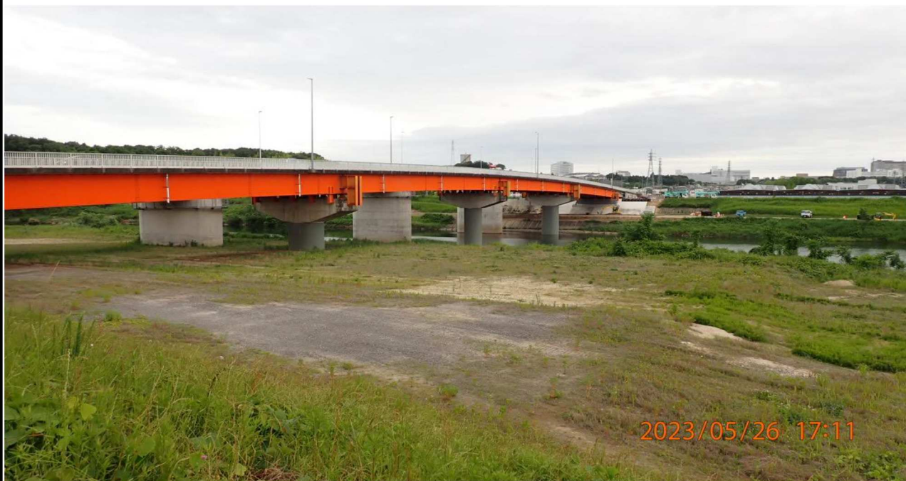
竜宮橋付近の様子（5）左岸37.8km付近より下流を撮影。
