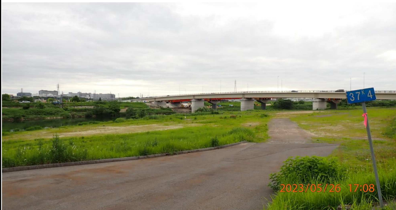
竜宮橋付近の様子（1）左岸37.4km付近より上流を撮影。
