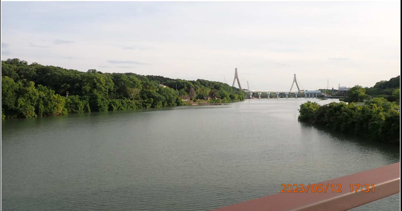
山室橋付近の様子（1）山室橋左岸より下流を撮影。
