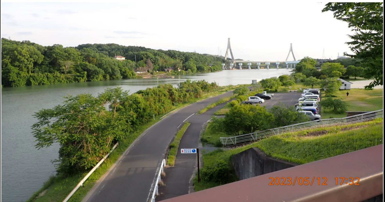
山室橋付近の様子（2）山室橋右岸より下流を撮影。
