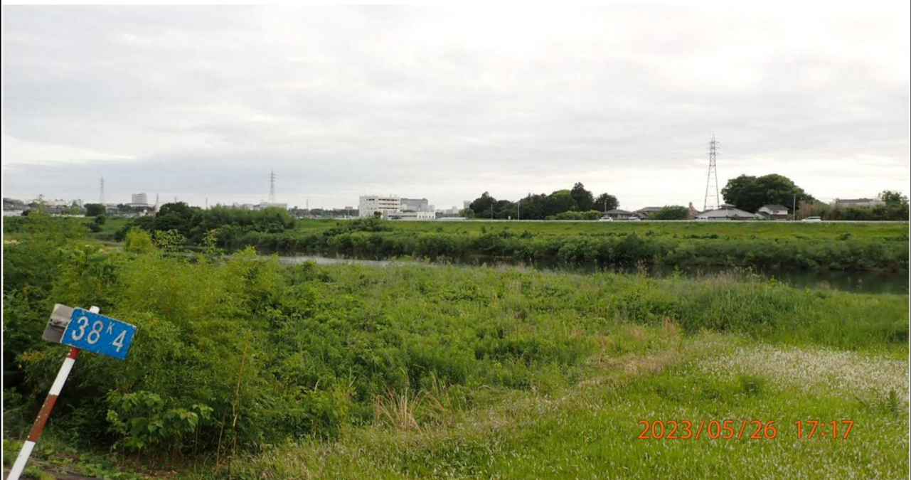
御立排水ひ管付近の様子（2）左岸38.4km付近より下流を撮影。
