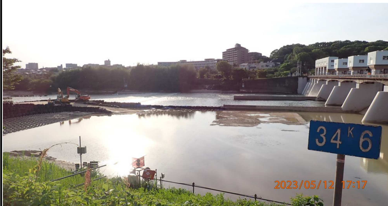
水源橋付近の様子（4）水源橋左岸より対岸を撮影。
