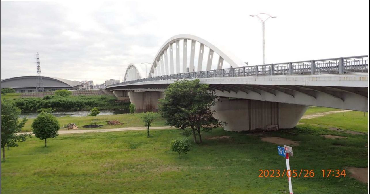
左岸39.4km付近より久澄橋を撮影。
