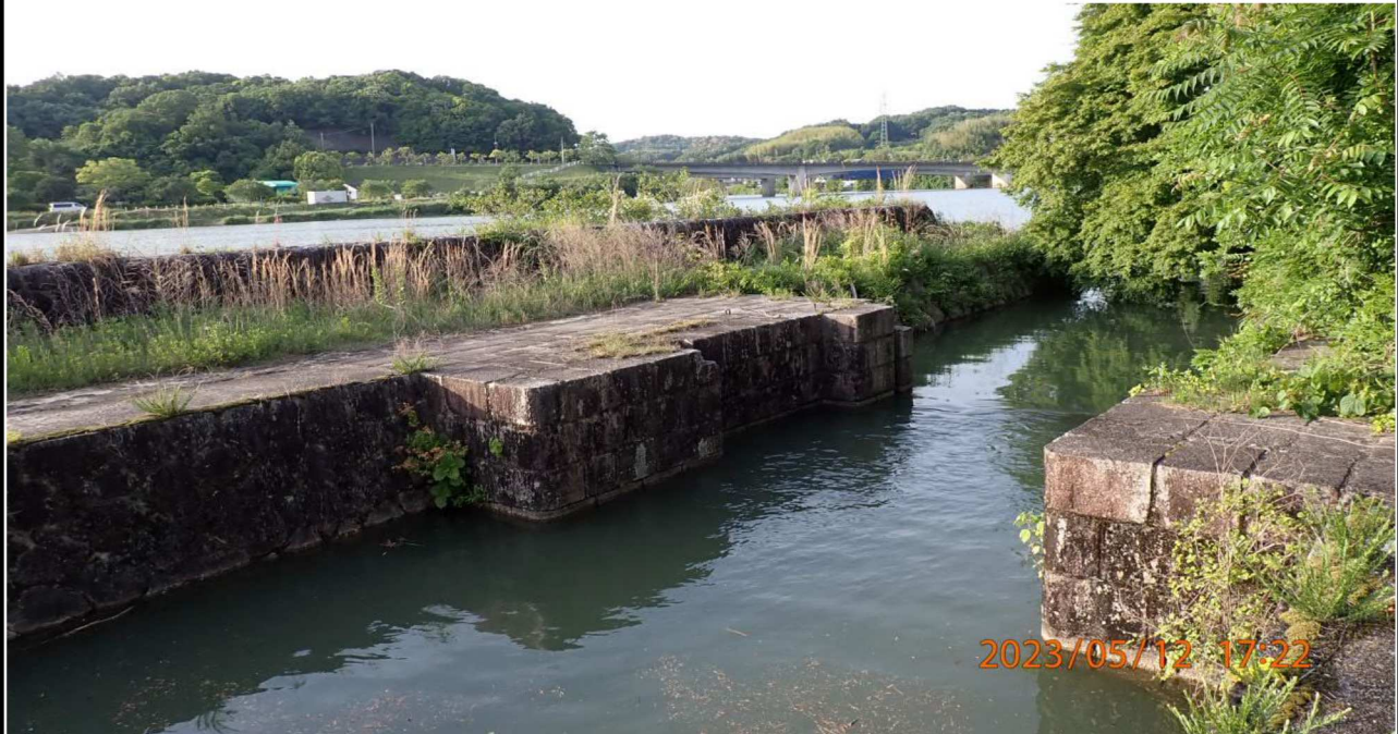
明治用水旧頭首工付近の様子（3）旧頭首工より上流を撮影。
