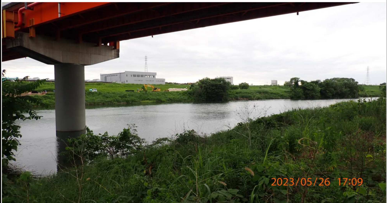
竜宮橋付近の様子（4）竜宮橋下より上流を撮影。
