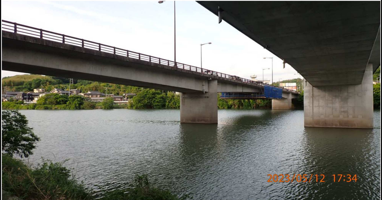
山室橋付近の様子（3）山室橋下（右岸）より上流を撮影。
