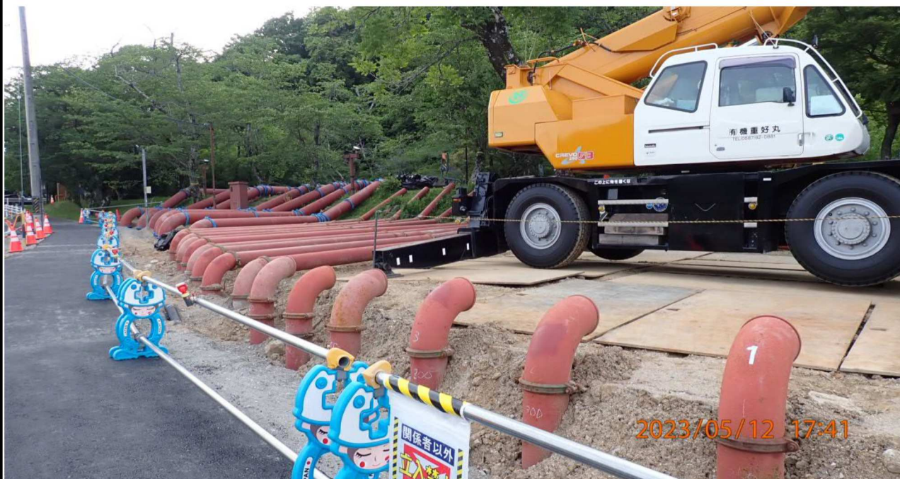
水源公園付近の様子（4） 多くの配管が埋設されていた。
