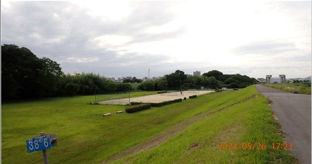
御立公園付近の様子（1）38.6km付近より上流側を撮影。
