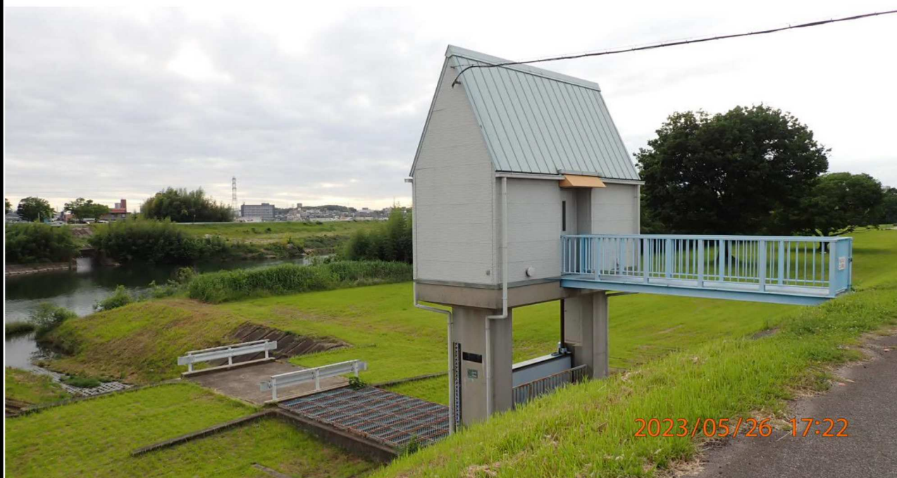
御立排水ひ管付近の様子（3）排水ひ管の全景。
