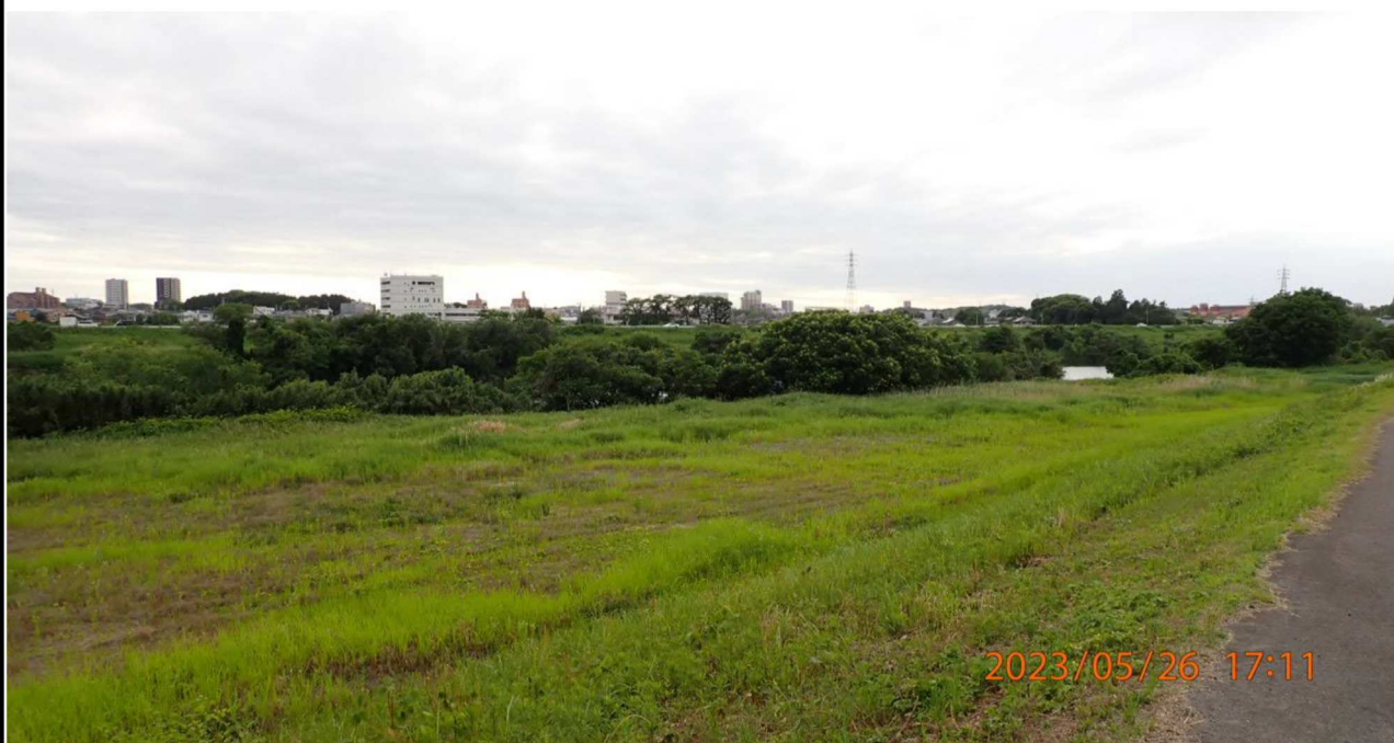
竜宮橋付近の様子（6）左岸37.8km付近より上流を撮影。
