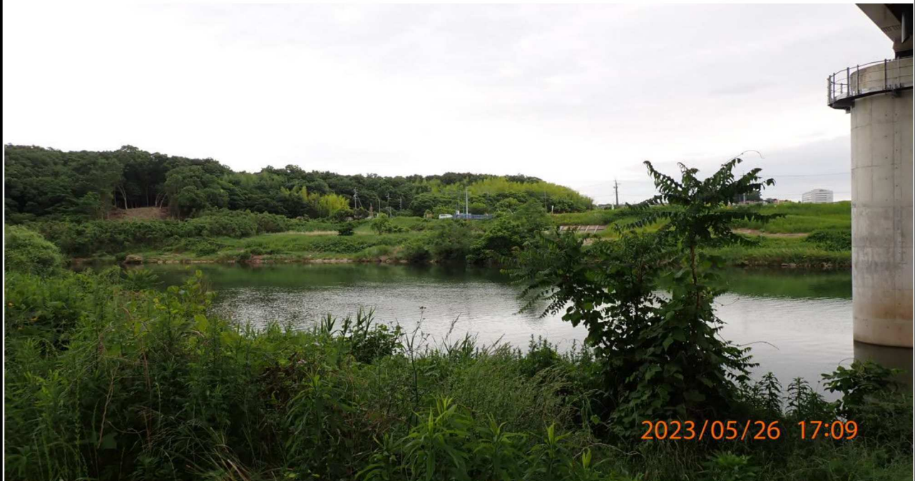
竜宮橋付近の様子（3）竜宮橋下より下流を撮影。
