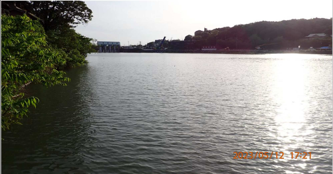
明治用水旧頭首工付近の様子（1）旧頭首工より下流を撮影。
