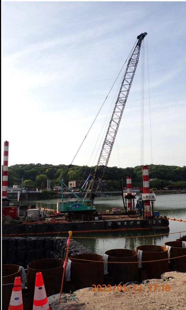
水源橋付近の様子（5） 水源橋（左岸）より 工事の様子を撮影。
