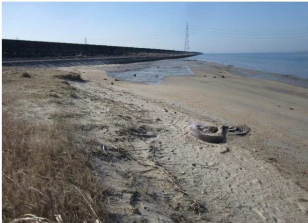
0.2km付近3月撮影 河口方向
