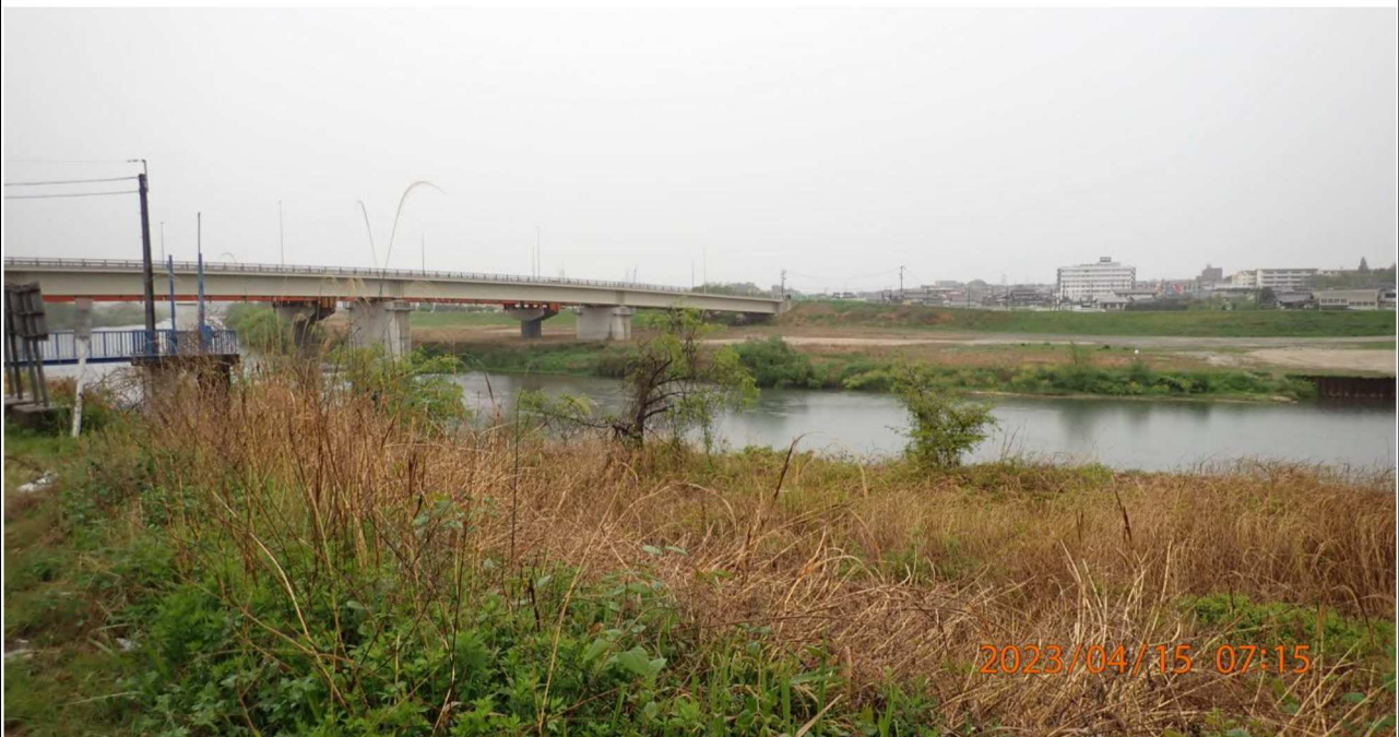
右岸37.6km付近の様子 (4)
