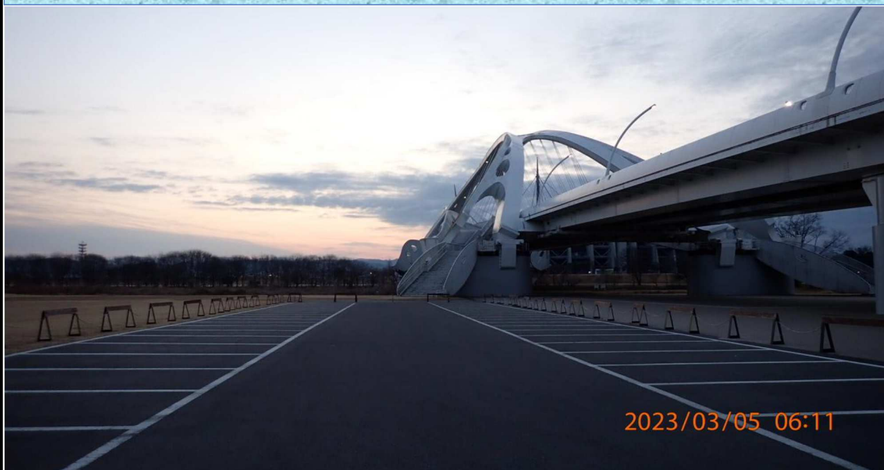
右岸豊田大橋付近の様子（1）右岸より見た豊田大橋を撮影。
