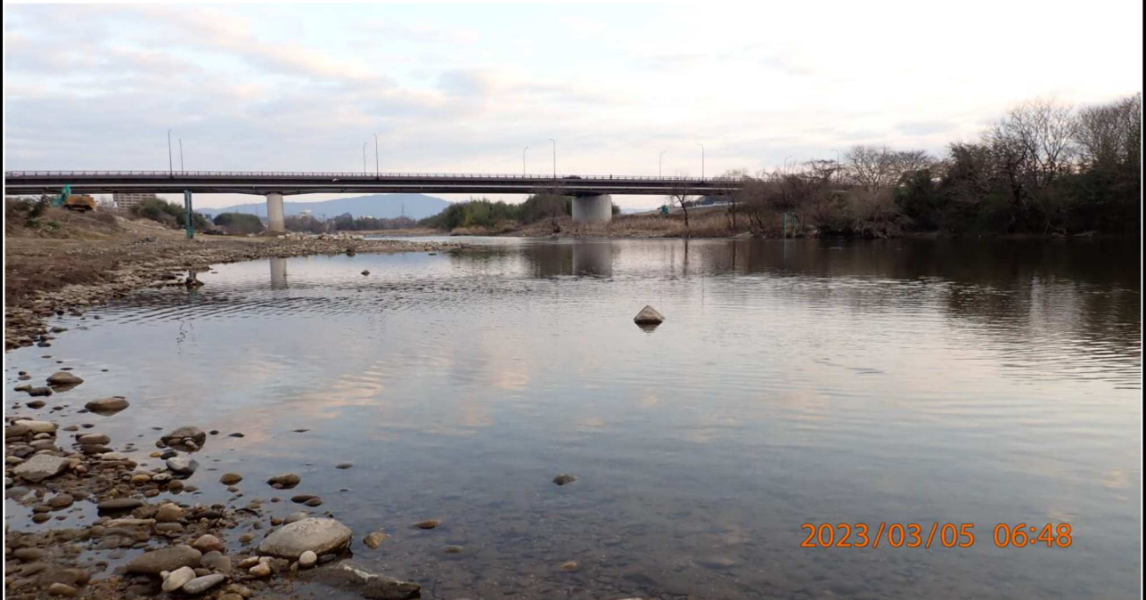
高橋付近の様子（7）右岸40.2km付近より上流を撮影。
