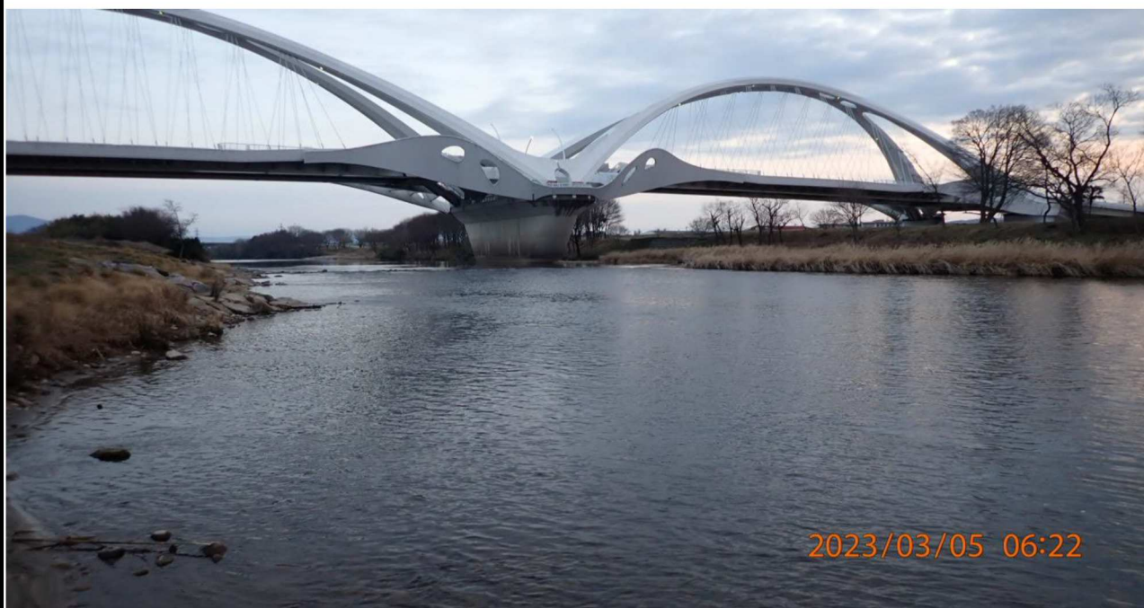
豊田大橋付近の様子（6）右岸39.7km付近より上流を撮影。
