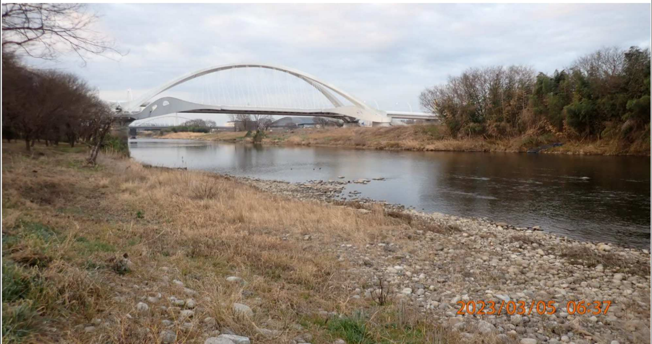
左岸豊田大橋付近の様子（4）左岸40.2km付近より下流を撮影。
