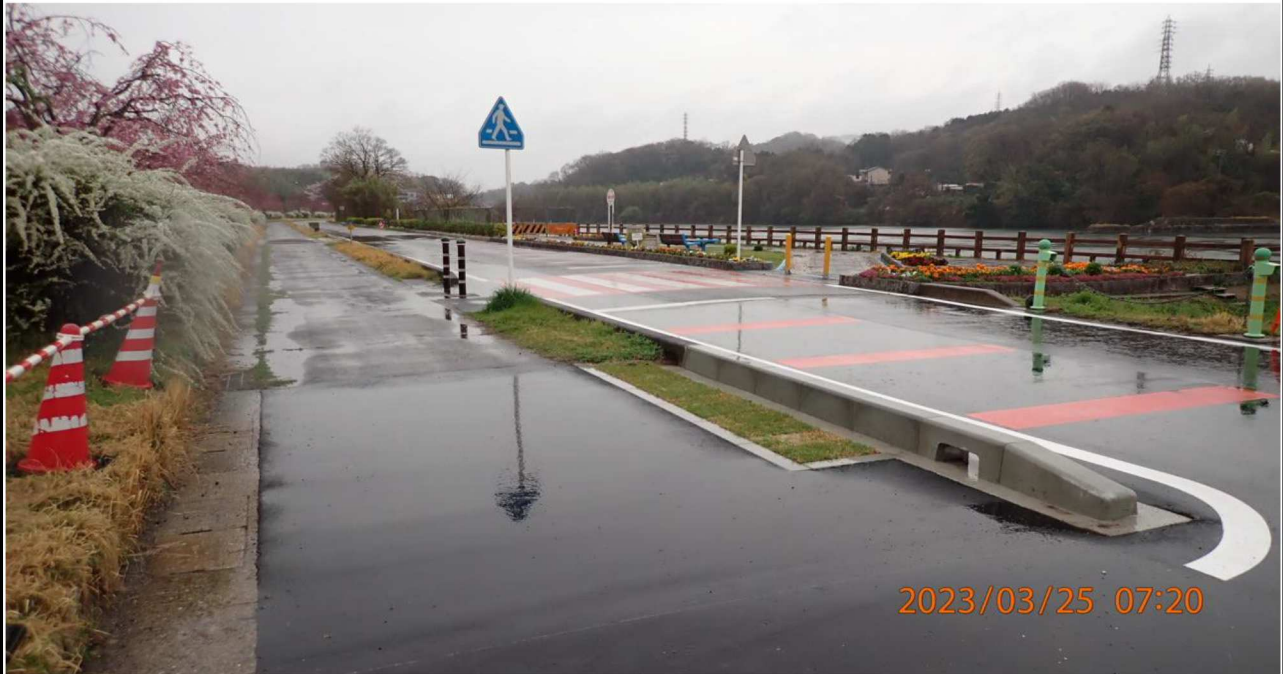
水源緑地付近の様子（3）歩道も工事前に復元されていた。
