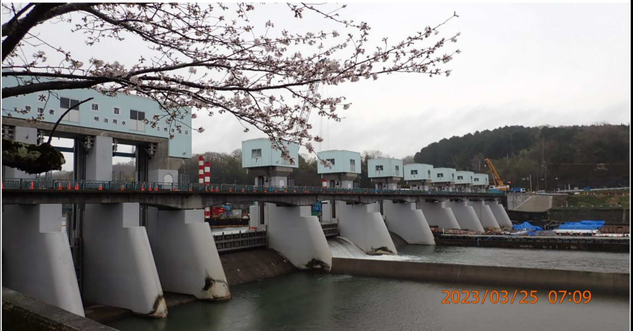
水源橋付近の様子（2）右岸より水源橋を撮影。 桜が咲き始めていた。
