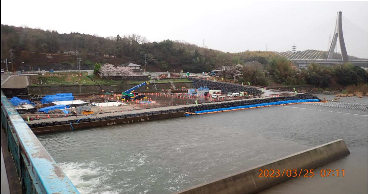
水源橋付近の様子（3）水源橋より対岸を撮影。
