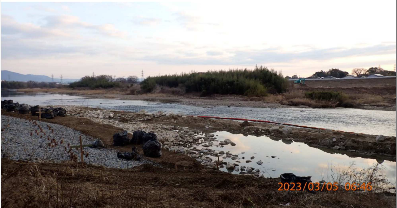
高橋付近の様子（6）右岸高橋下より上流を撮影。 この付近では護岸工事が行われていた。
