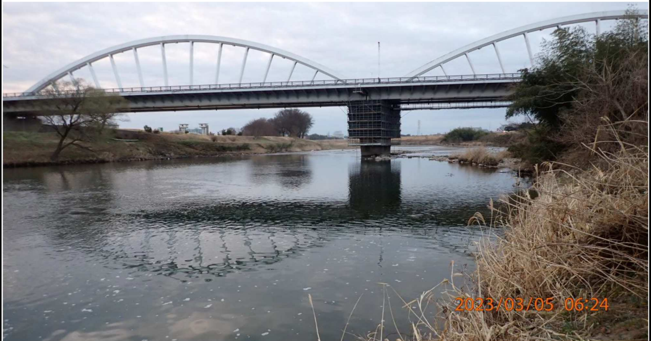
右岸豊田大橋付近の様子（7）右岸39.6km付近より下流を撮影。流れは緩やかであった。
