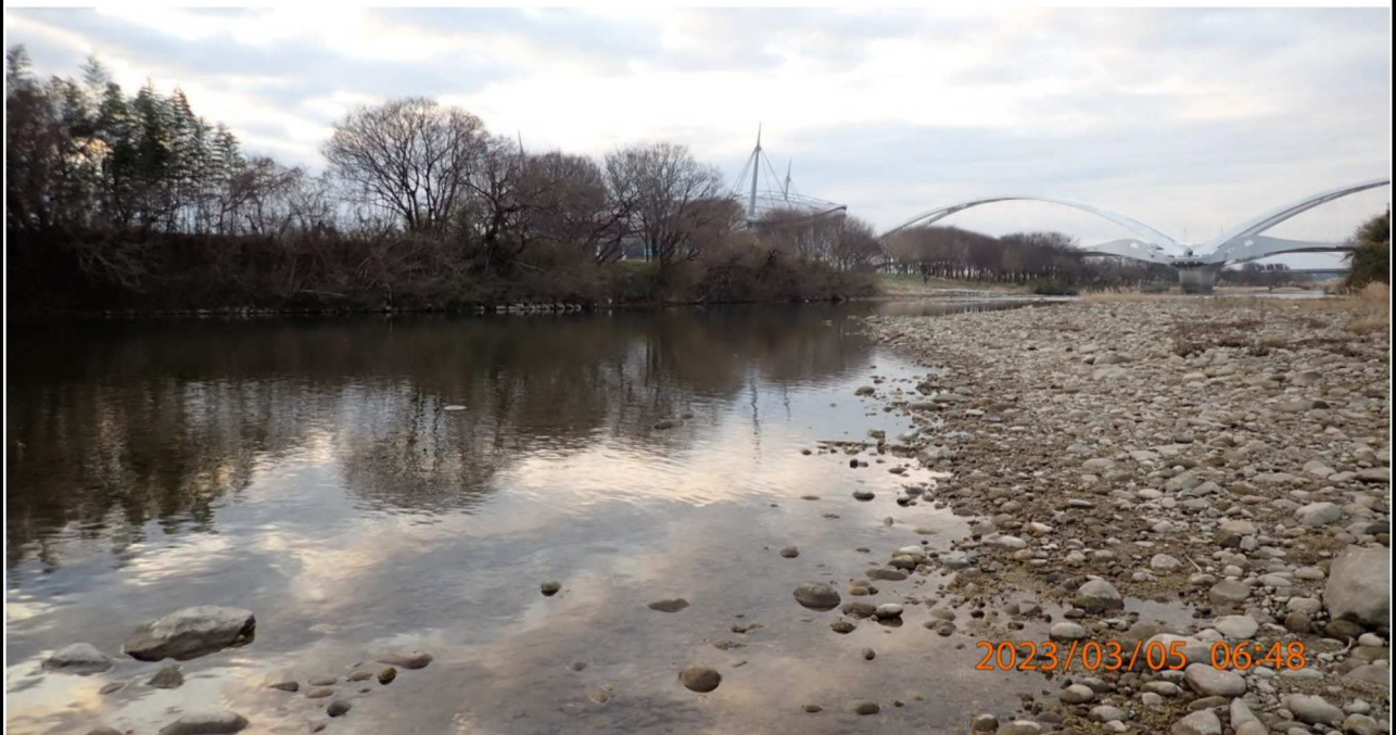
高橋付近の様子（8）右岸40.2km付近より下流を撮影。
