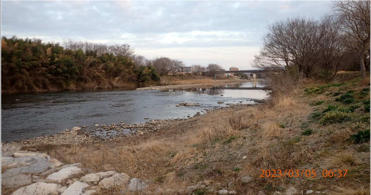
左岸豊田大橋付近の様子（3）左岸40.2km付近より上流を撮影。
