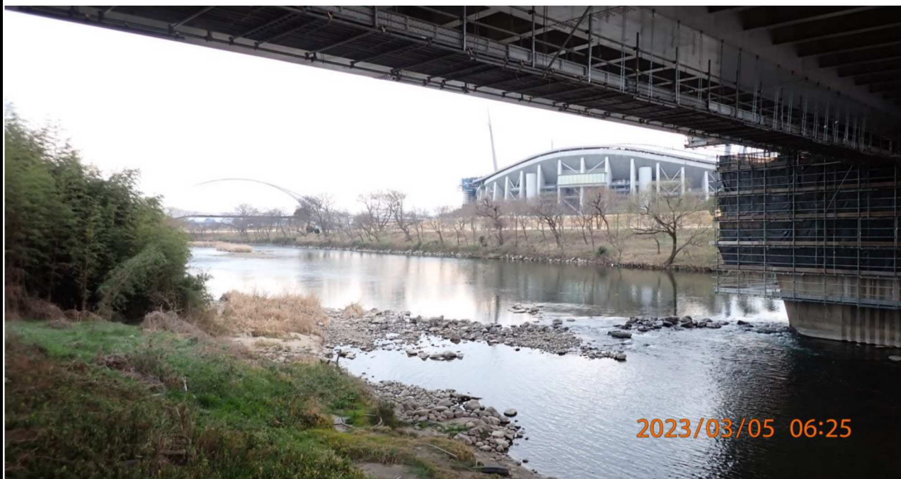
久澄橋付近の様子（2）右岸久澄橋下より上流を撮影。
