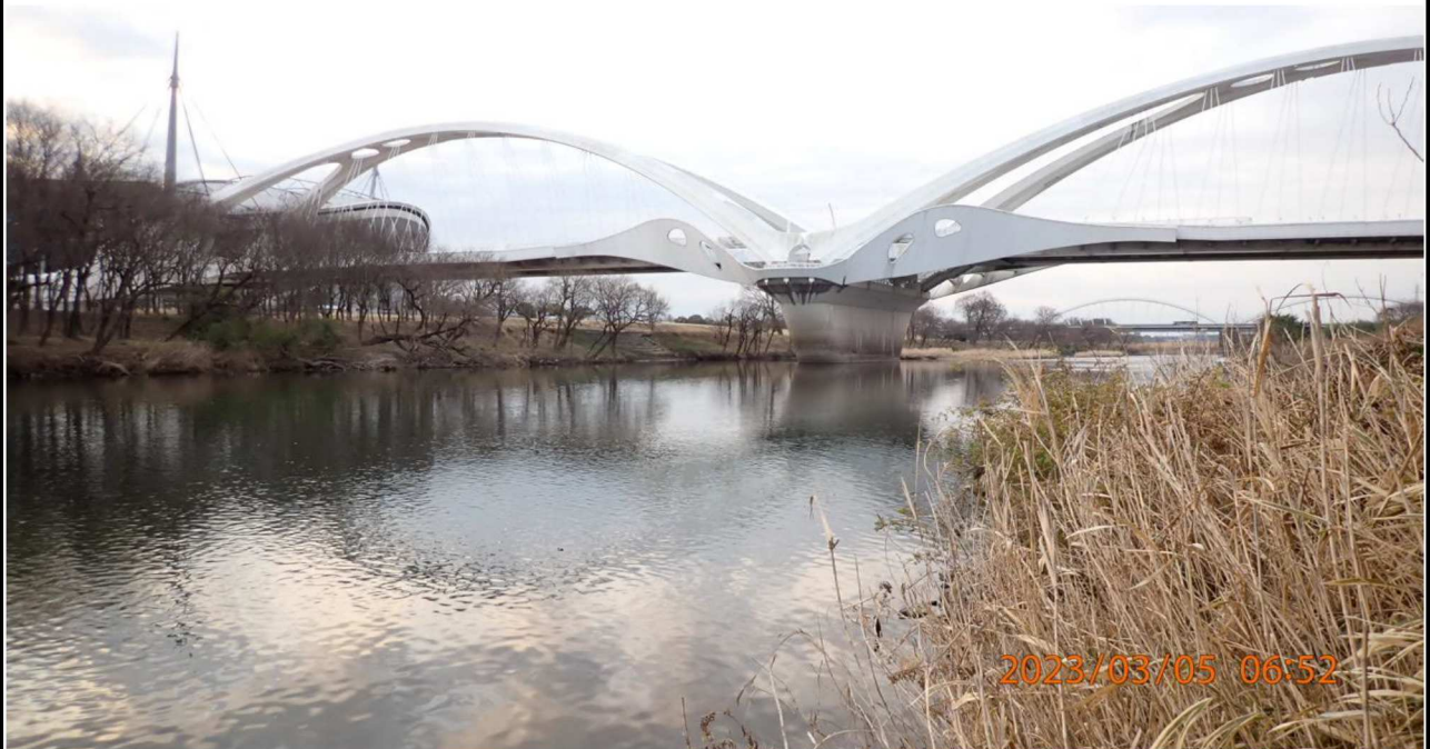
豊田大橋付近の様子（1）右岸40.0km付近より下流を撮影。
