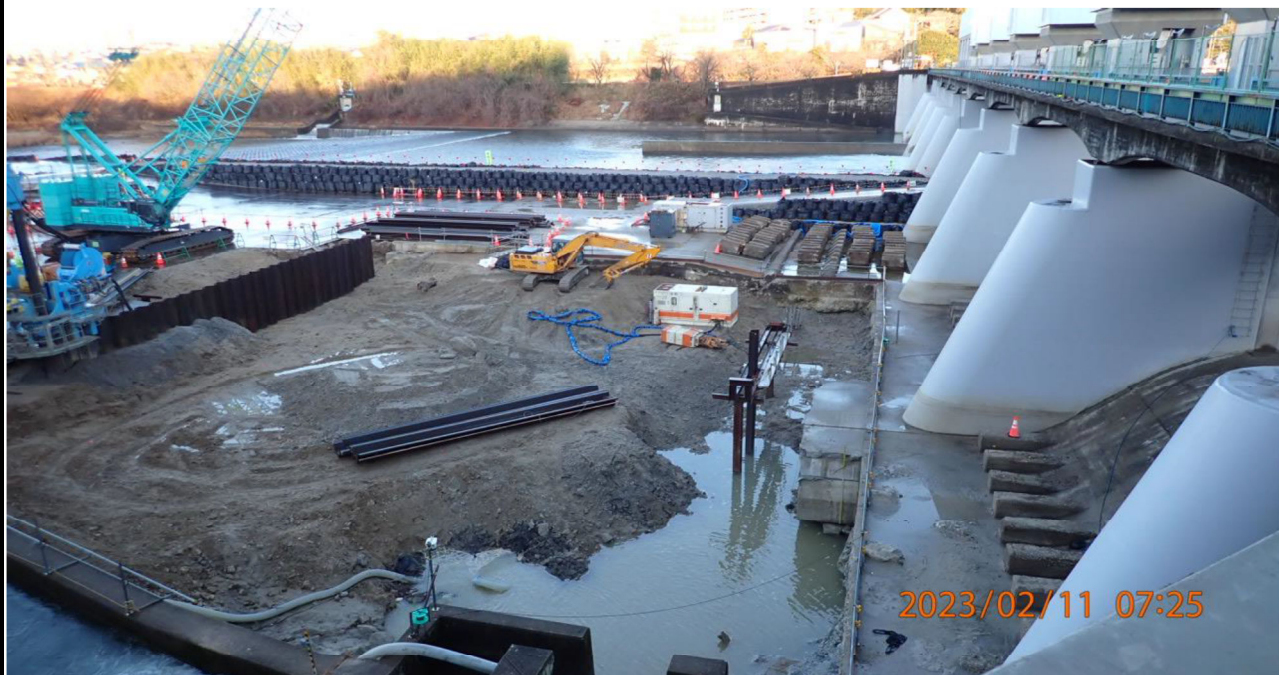
水源橋付近の様子（6）水源橋左岸から対岸を撮影。 工事範囲の大きさがよくわかる。
