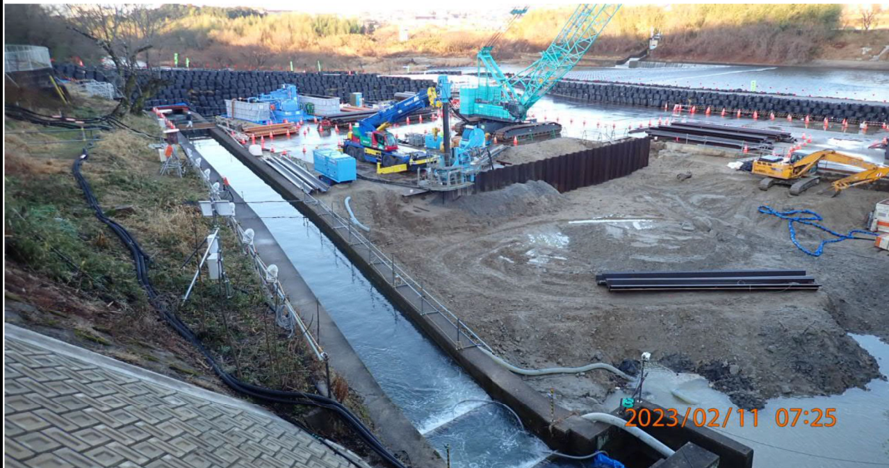
水源橋付近の様子（5）水源橋左岸から下流を撮影。 色々な重機が活躍中。
