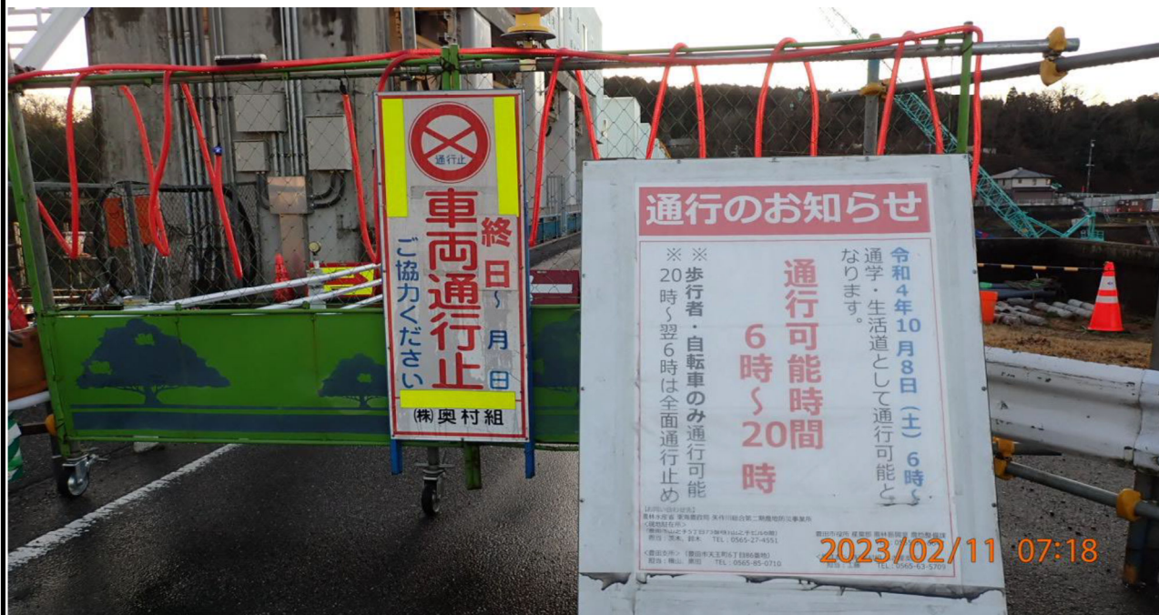
水源橋付近の様子（13）右岸より水源橋を撮影。 通行時間などが制限されていた。
