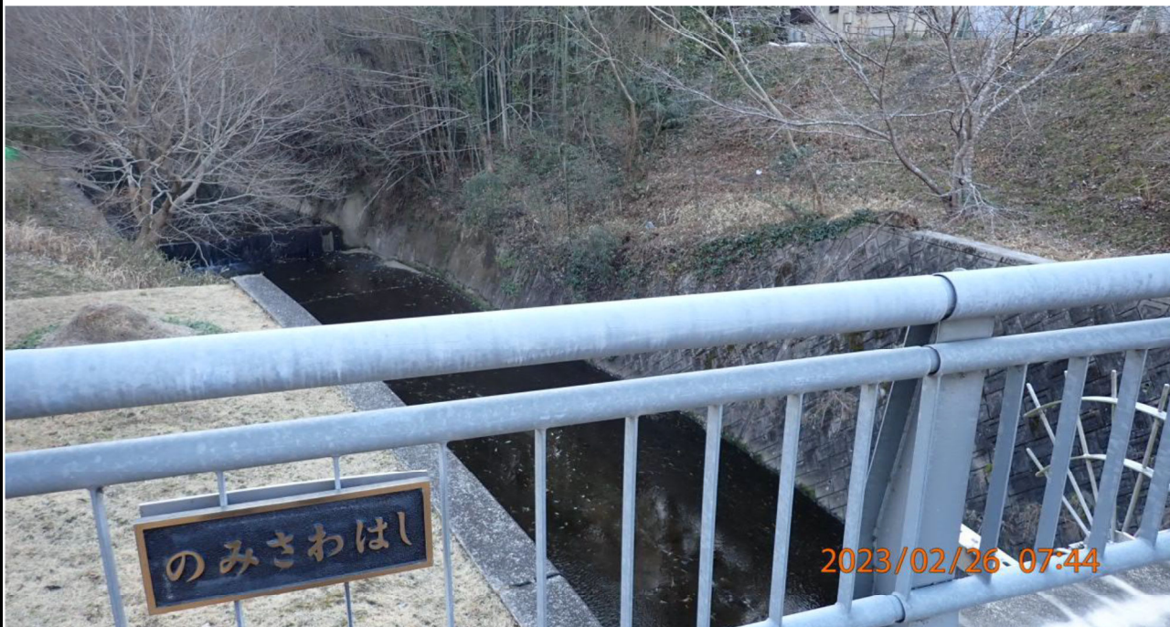
鵜の首橋付近の様子（10）左岸37.2km付近の榎尾川合流地点を撮影。合流する榎尾川を望む。
