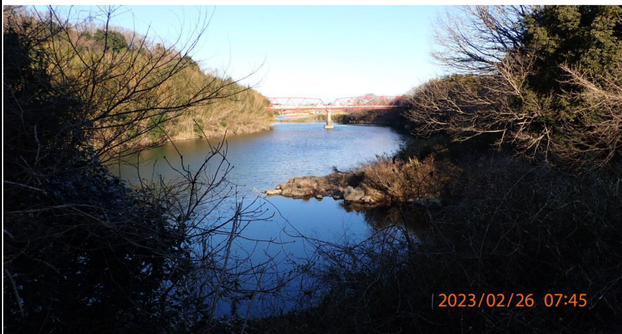
鵜の首橋付近の様子（12）左岸37.2km付近の櫛尾川合流地点を撮影。野見沢橋から上流を望む。
