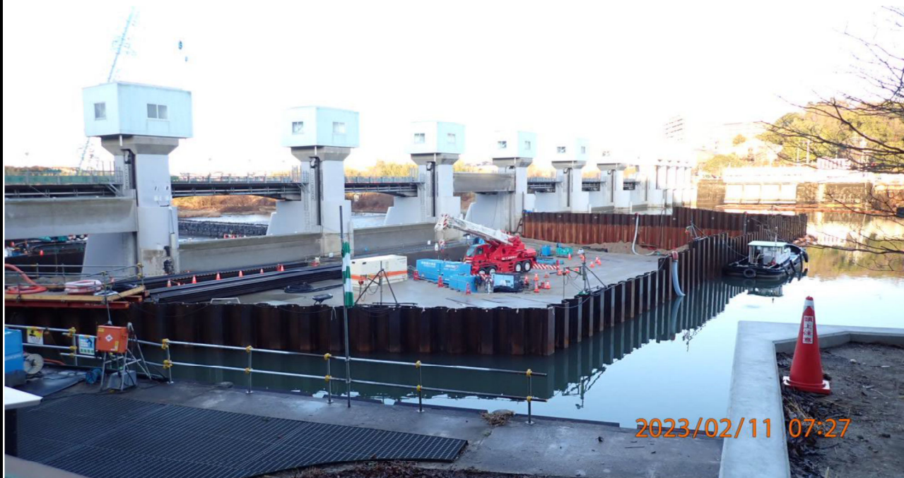
水源橋付近の様子（20）左岸（上流側）より水源橋を撮影。
