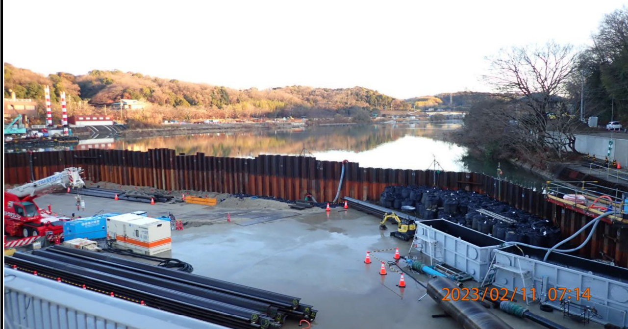
水源橋付近の様子（18）水源橋（左岸寄り）から上流を撮影。
