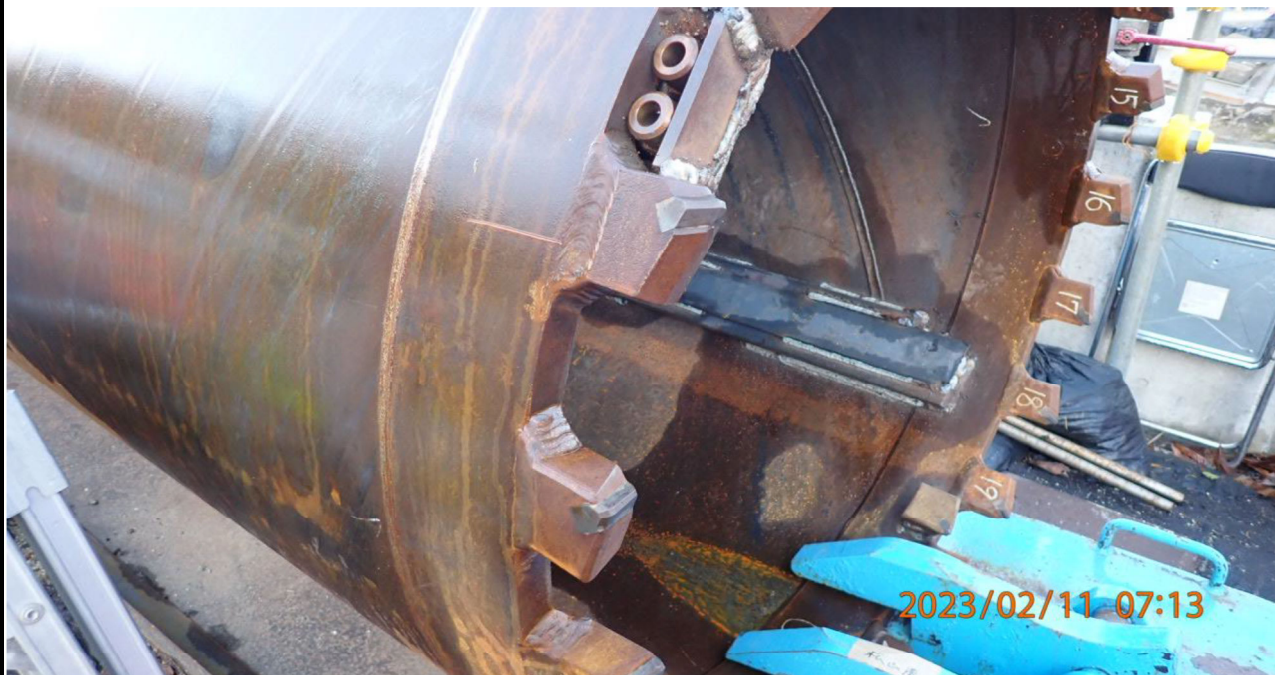
水源橋付近の様子（4）左岸で見た重機の一部。 刃先は超鋼工具のようだ。
