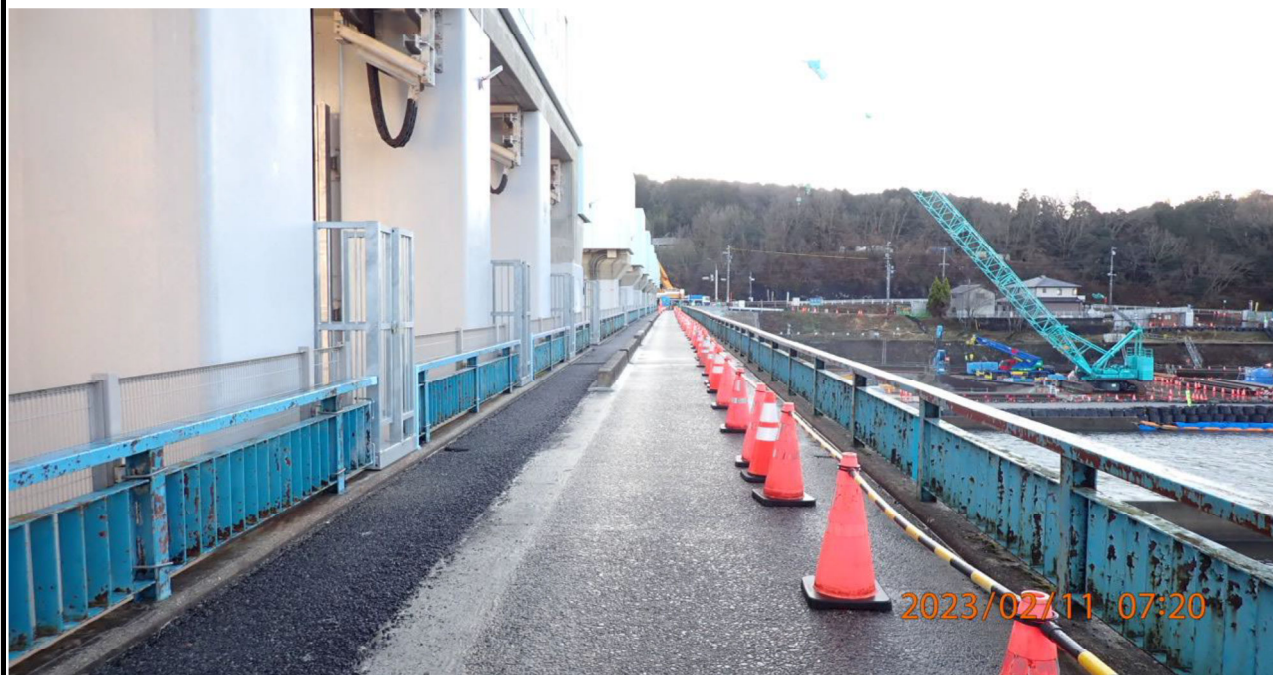
水源橋付近の様子（14）右岸より水源橋を撮影。
