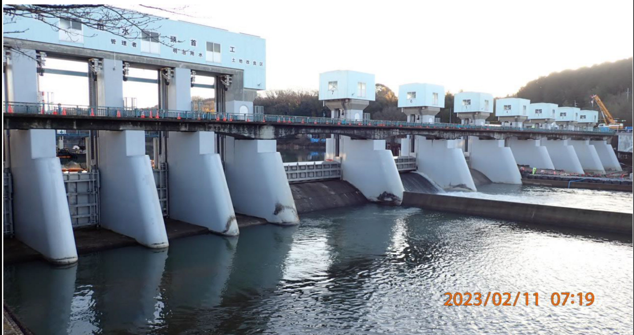
水源橋付近の様子（12）右岸（下流側）より水源橋を撮影。
