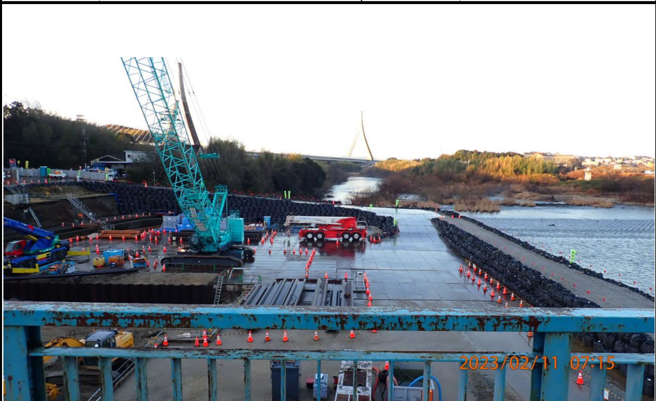
水源橋付近の様子（7）水源橋（左岸寄り）から下流を撮影。
