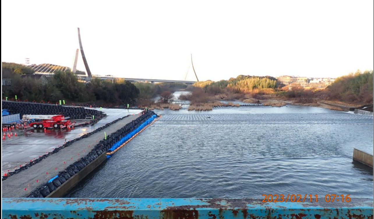
水源橋付近の様子（8）水源橋（中央寄り）から下流を撮影。
