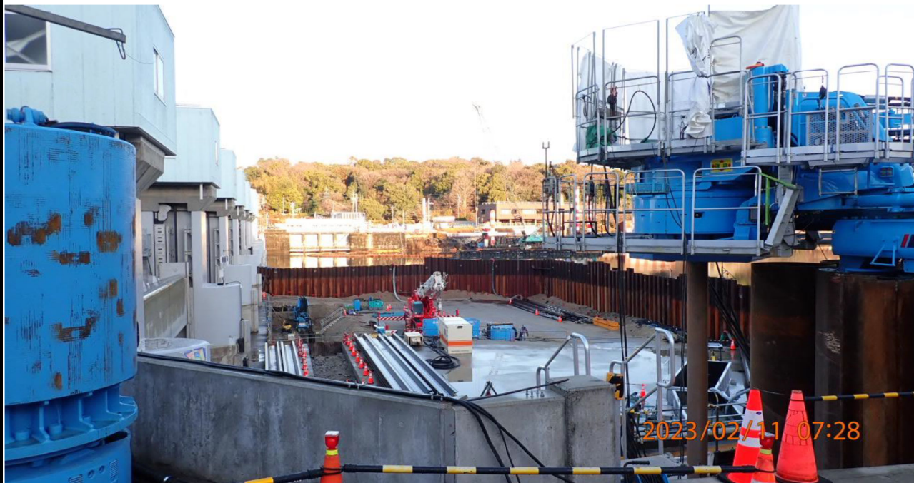
水源橋付近の様子（19）左岸より対岸を撮影。
