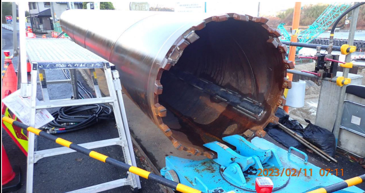
水源橋付近の様子（3）左岸で見た重機の一部。 掘削工事の工具のような筒が用意されていた。
