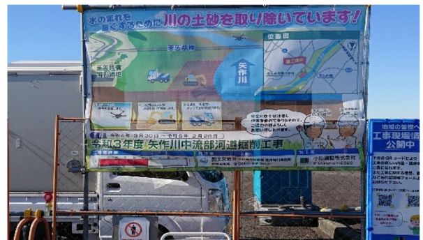
① 美矢井橋付近で河道掘削工事(18.4Km)
