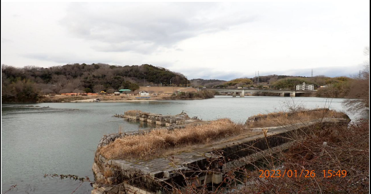
水源橋付近の様子（4） 35km付近より上流を撮影。
