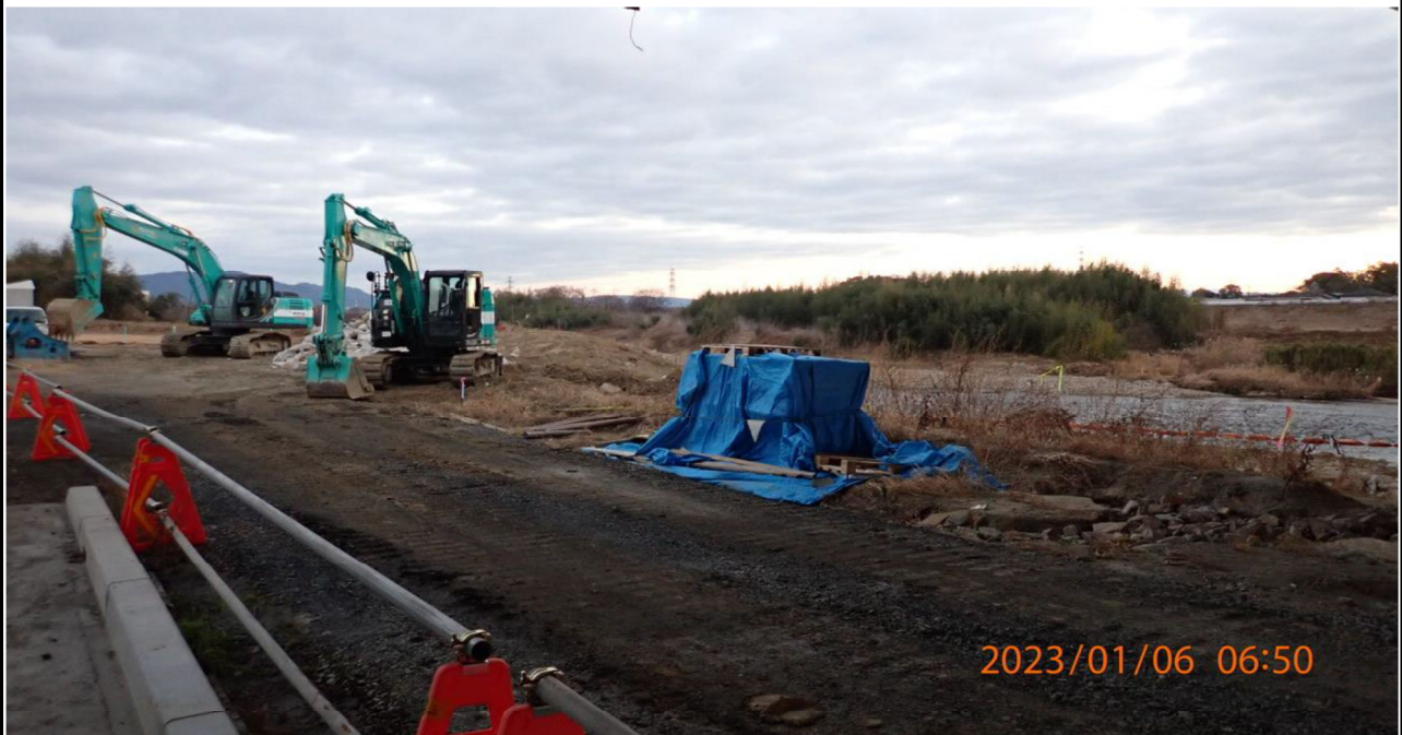
高橋付近の様子（2） 右岸橋下より上流を撮影。
