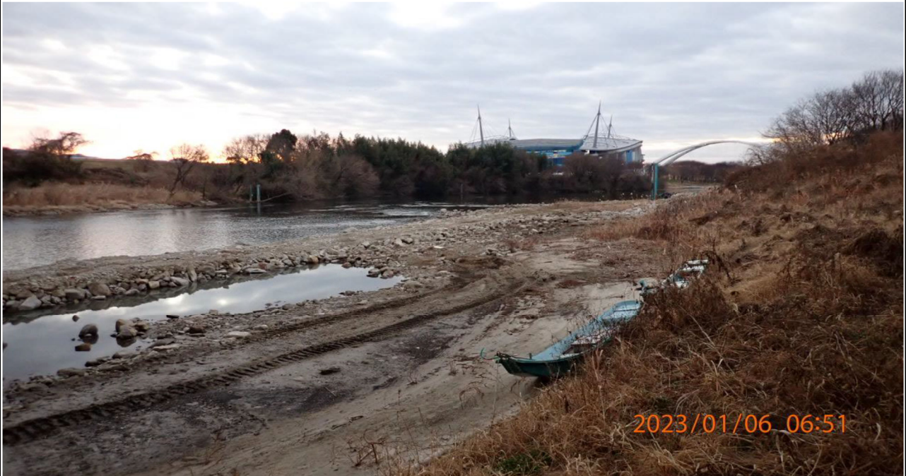
高橋付近の様子（3） 右岸橋下の河川敷より下流を撮影。
