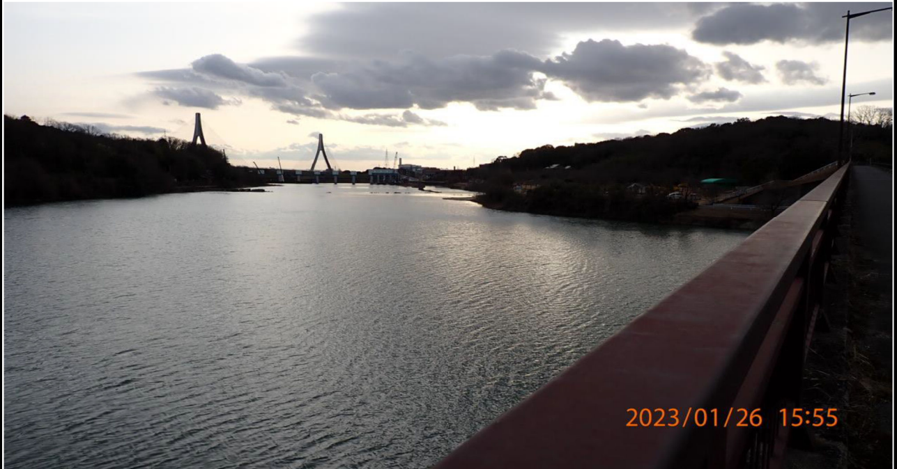
山室橋付近の様子（1） 左岸の山室橋より下流を撮影。
