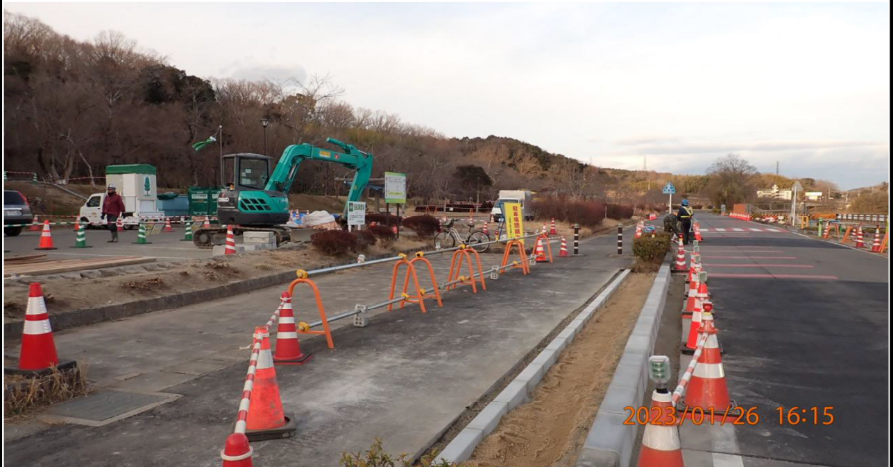
水源橋付近の様子（7） 歩道では修復工事が行われていた。
