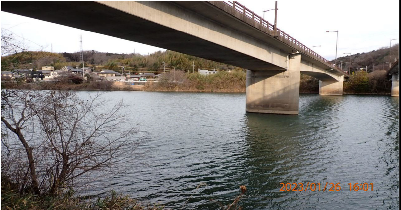
山室橋付近の様子（3） 右岸の山室橋より上流を撮影。
