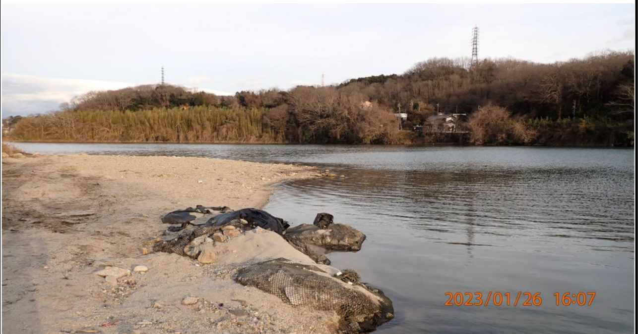
水源橋付近の様子（2） 右岸35.2km付近より上流をを撮影。
