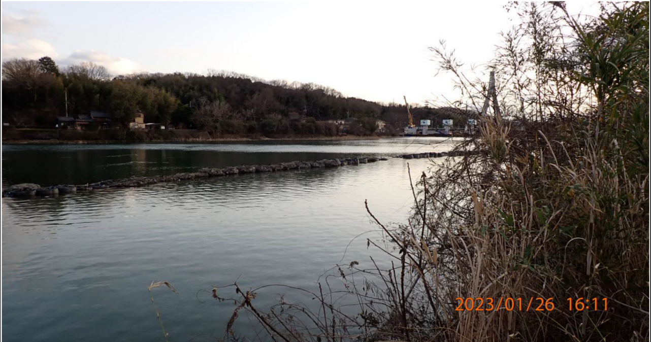
水源橋付近の様子（3） 右岸35.2km付近より下流を撮影。
