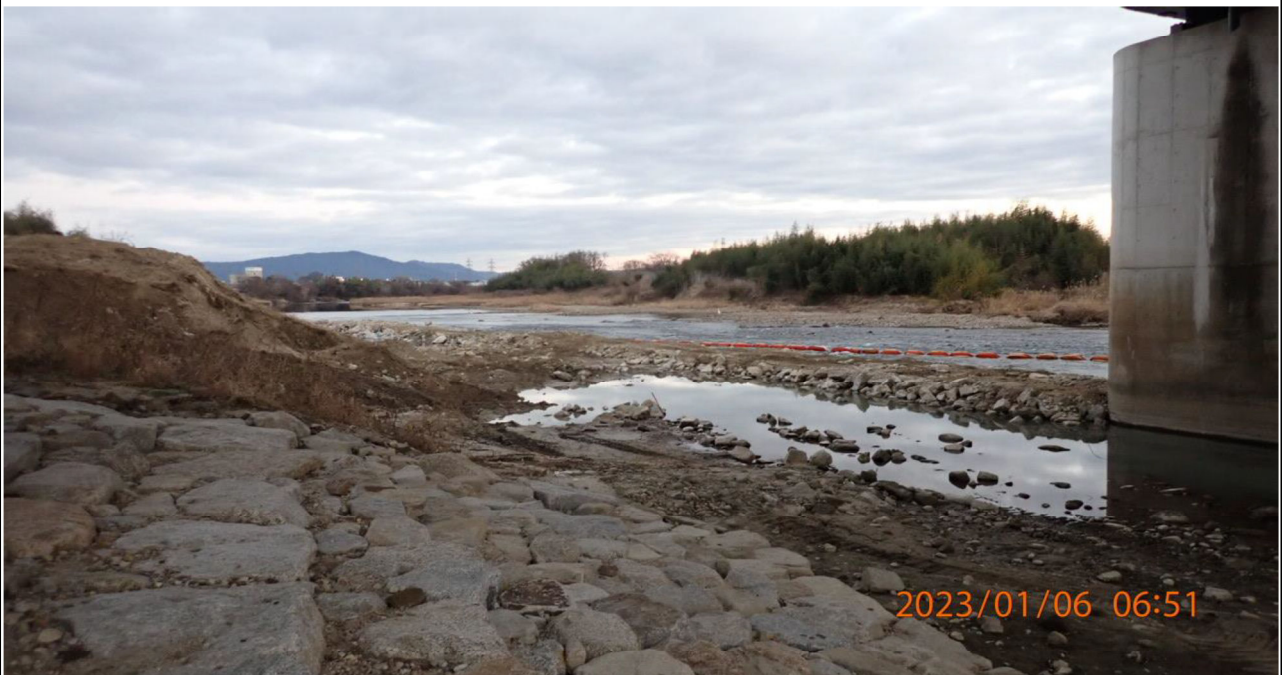
高橋付近の様子（4） 右岸橋下の河川敷より上流を撮影。
