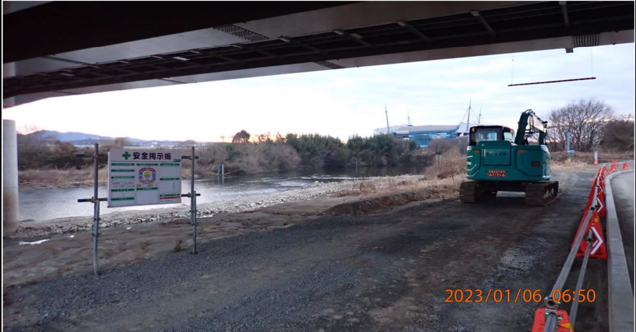
高橋付近の様子（1） 右岸橋下より下流を撮影。
