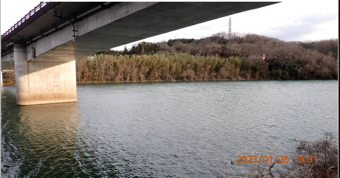
山室橋付近の様子（4） 右岸の山室橋より下流を撮影。
