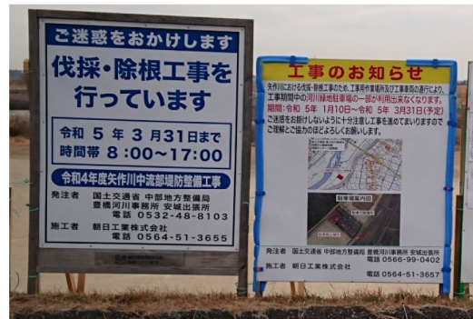
① 「河川の伐採・除根工事」左岸でも
