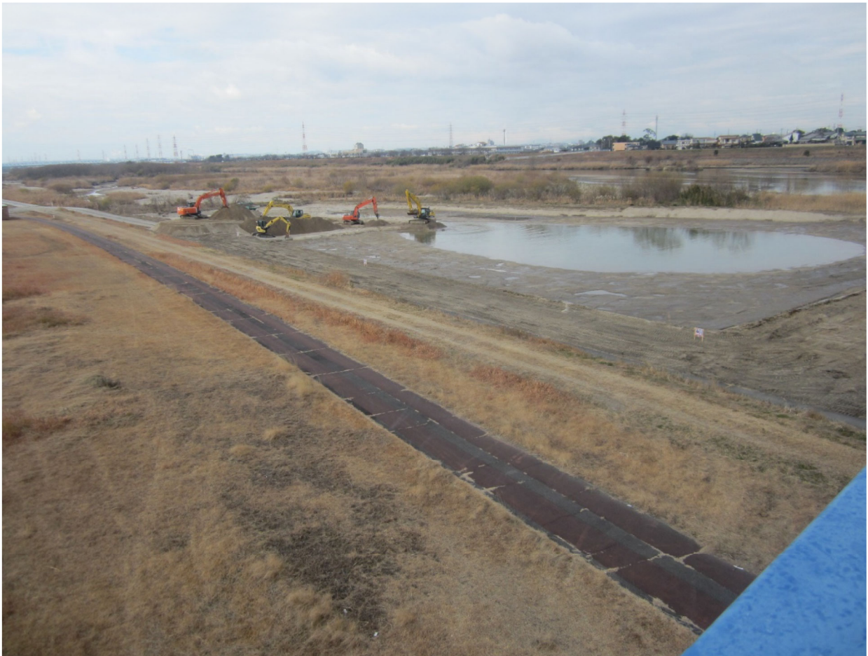
上塚橋から下流方向堤防道路左岸から撮影 これからの進捗が楽しみです
