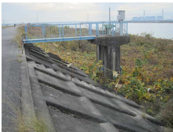
小栗排水ひ管 管理者：中部地方建設局豊橋工事事務所 巾1.0m、高1.0m、長31.1m
