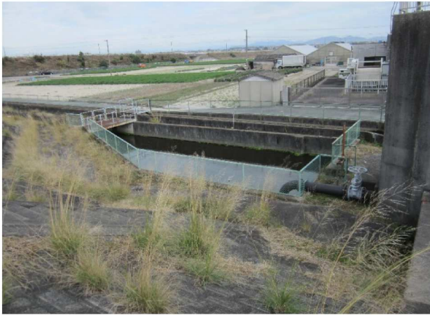
小栗排水ひ管の裏のり側 排水路に繋がっている
